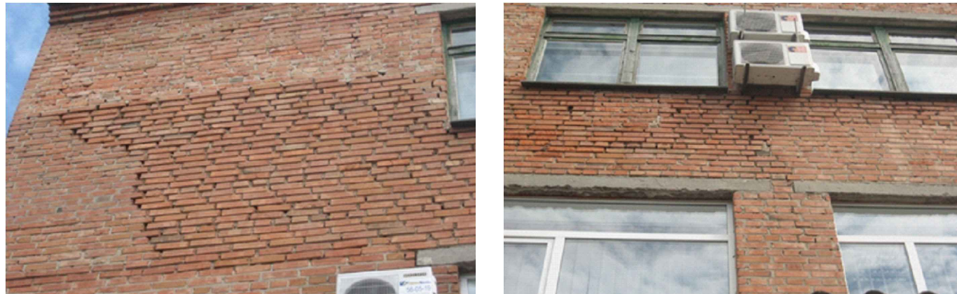
Неякісне виконання кладки при закладення віконних отворів
