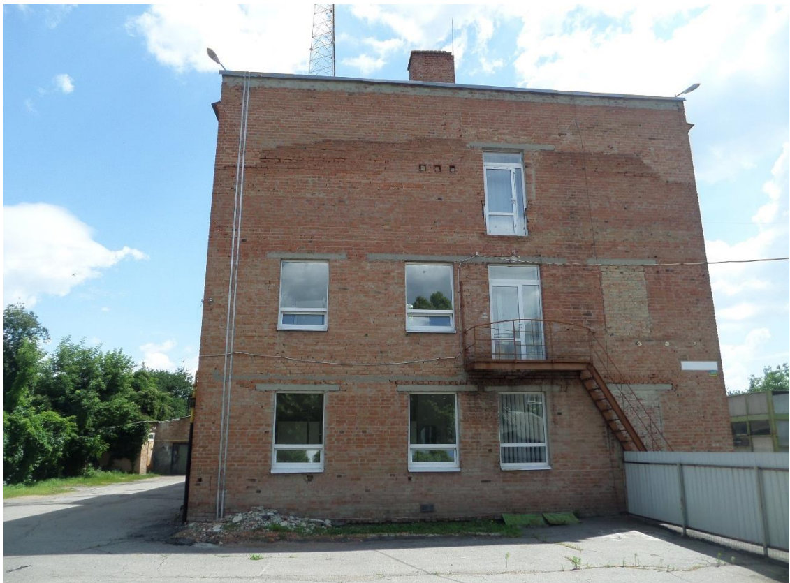
Рис. 1.3 – Загальний вид будівлі в осях В-А
