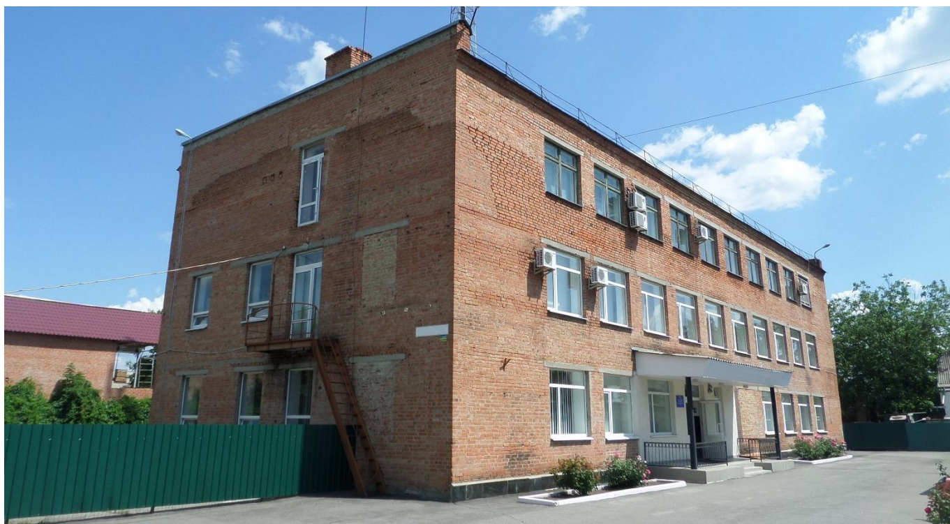
Рис. 1.1 – Загальний вид будівлі в осях 1-4
