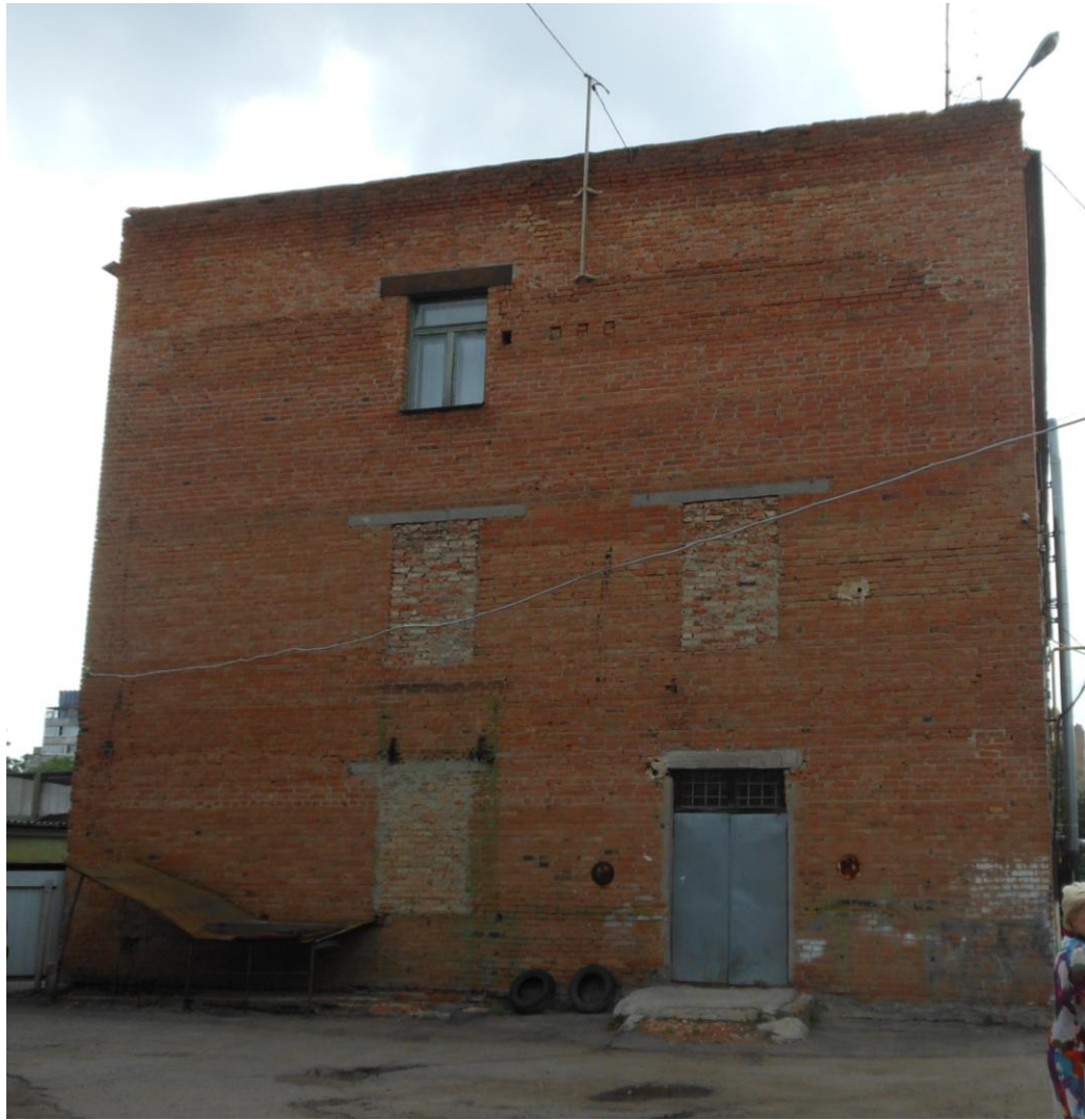
Рис. 1.4 – Загальний вид будівлі в осях А-В
