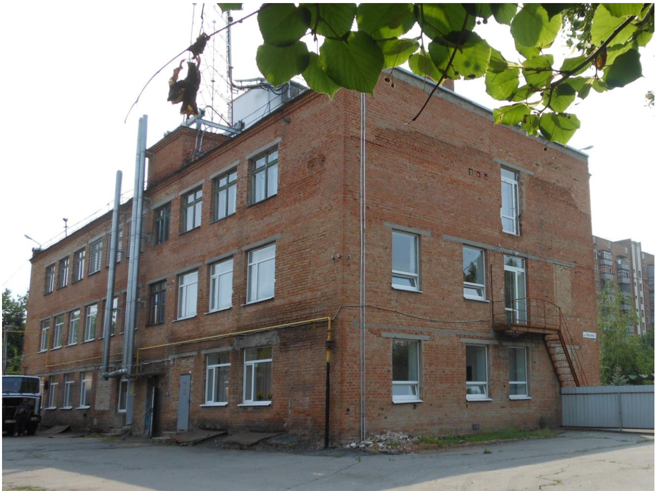
Рис. 1.2 – Загальний вид будівлі в осях 4-1
