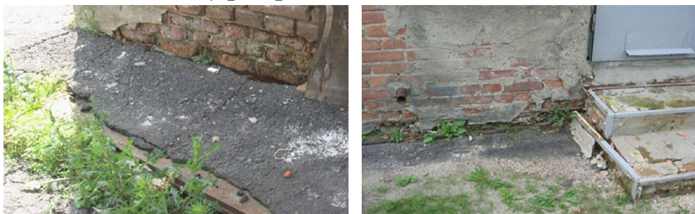
Руйнування вимощення, біозабруднення, руйнування сходів
