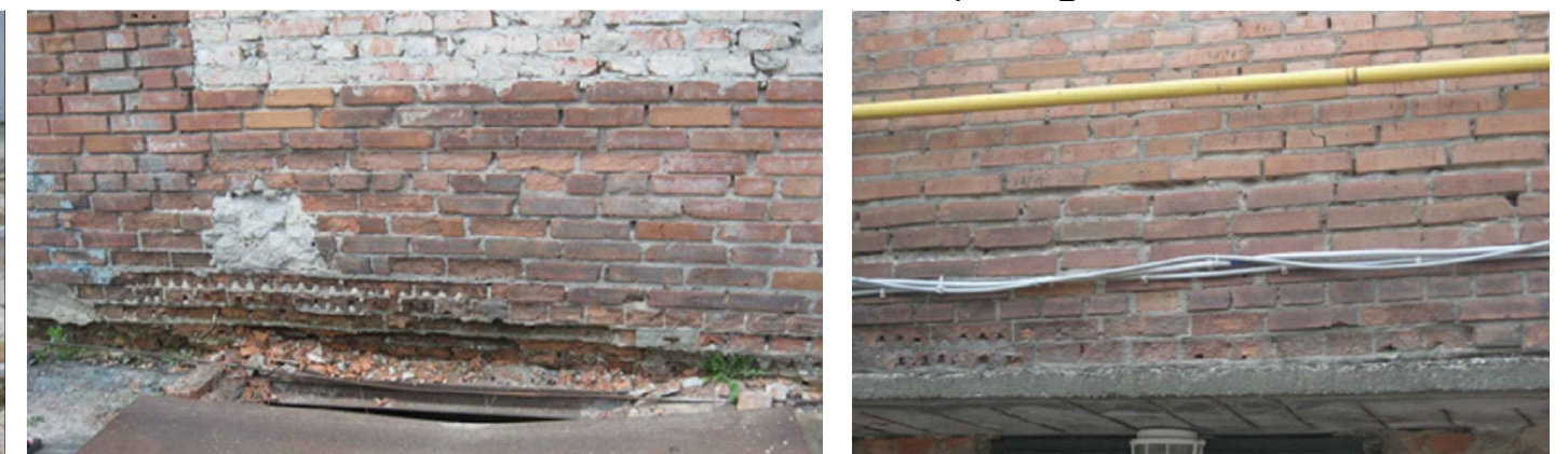
Замочування та руйнування цегляної кладки цоколю та козирьку
