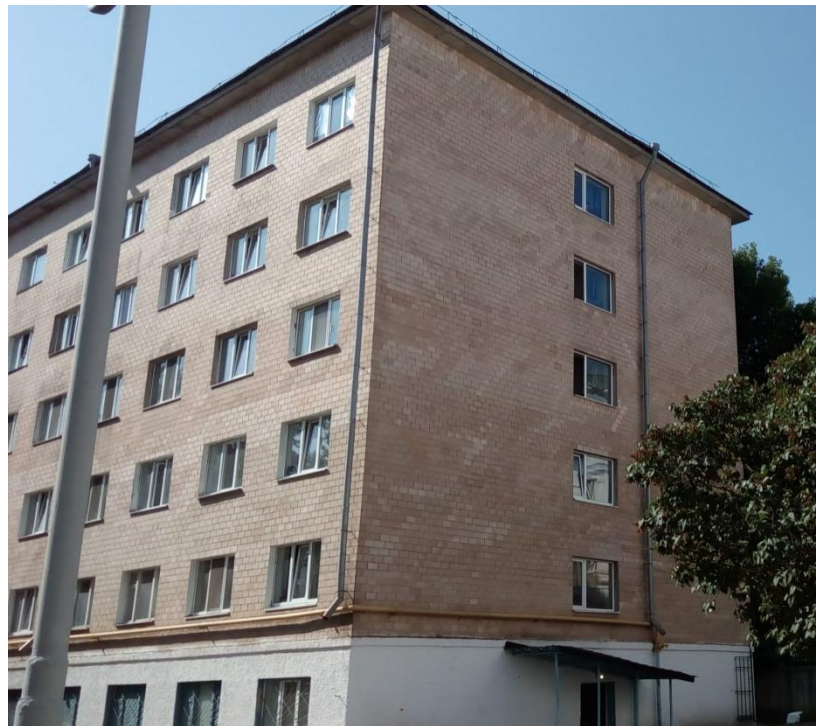
Рис. 1.3. Загальний вигляд будівлі гуртожитку №4 по осям В-Ж
