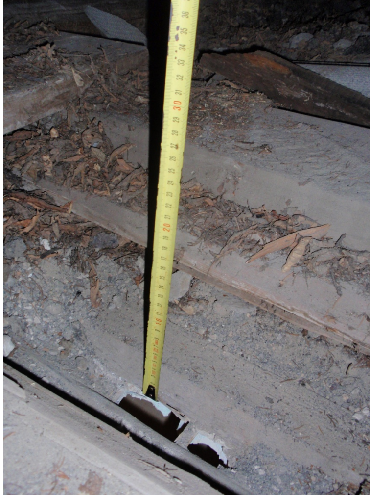
Рис. 2.8 – Шурфування перекриття учбового корпусу Полтавського обласного центру науково-технічної творчості учнівської молоді ПОР.
