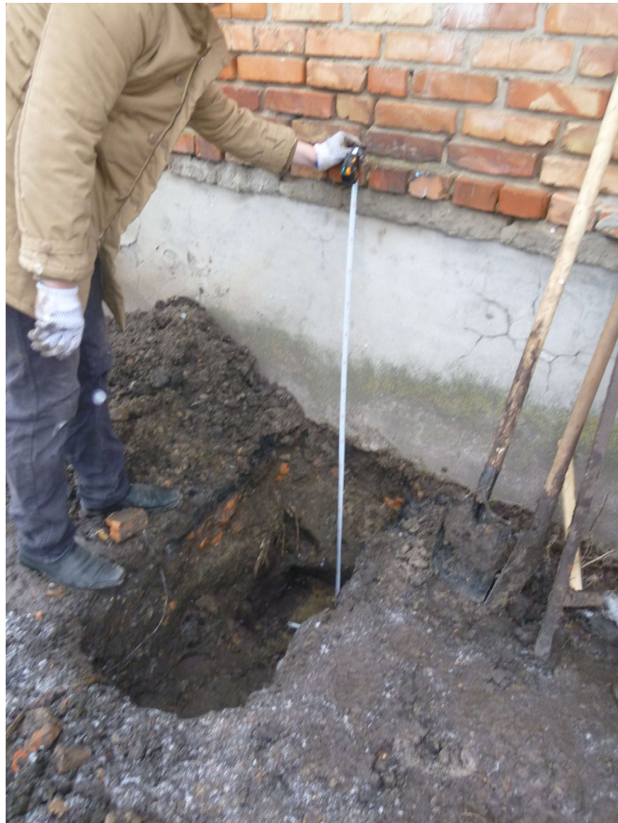
Рис. 2.17 – Фундамент будівлі ФАП в осях 1-4
