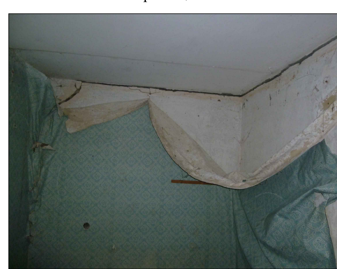
Відшарування перегородок від стелі у приміщеннях
