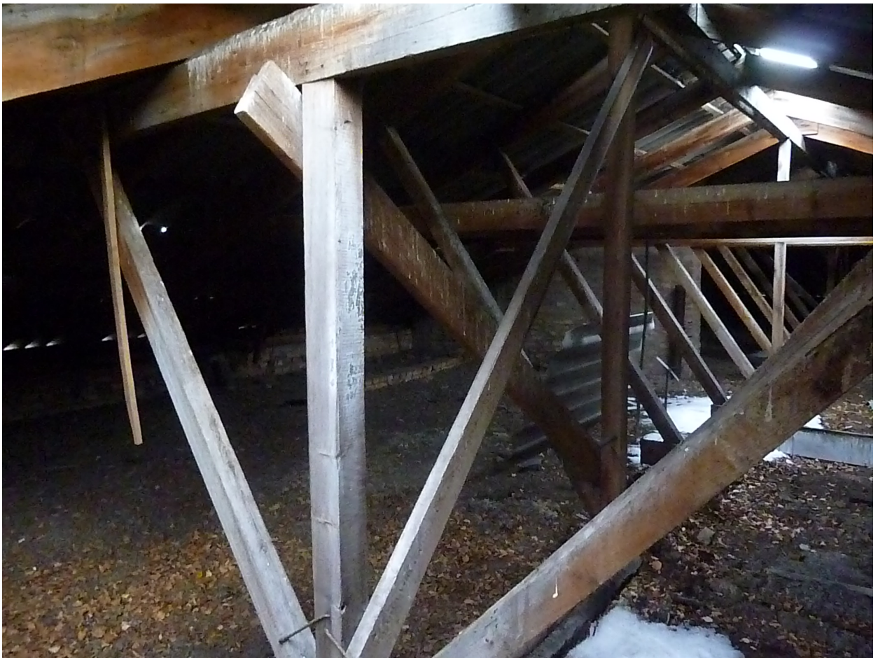
Рис. 2.19 – Загальний вигляд дерев'яної кроквяної системи горища
