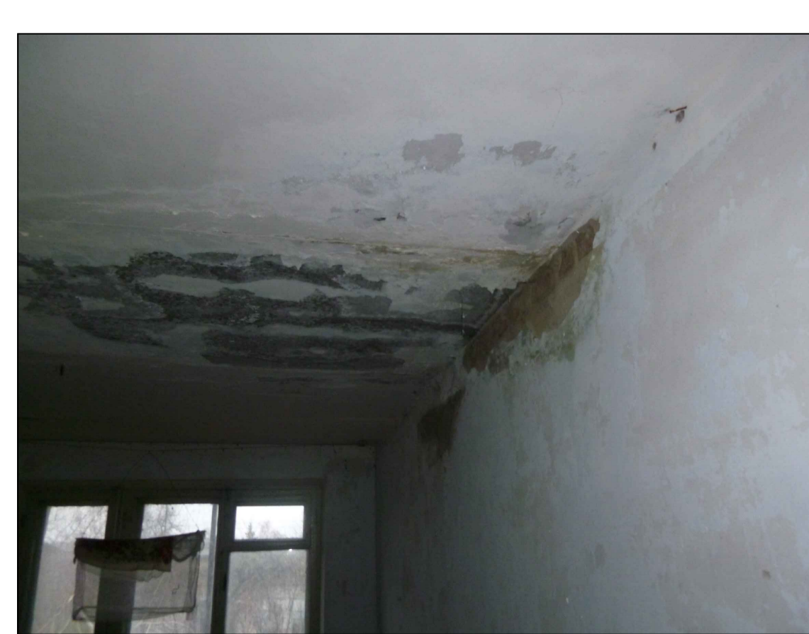
Сліди замокання на поверхні стелі та стін зсередини приміщень будівлі ФАП
