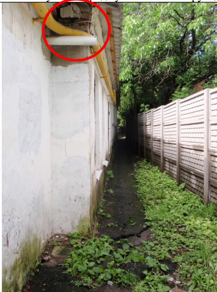
Руйнування вимощення та цегляної кладки
