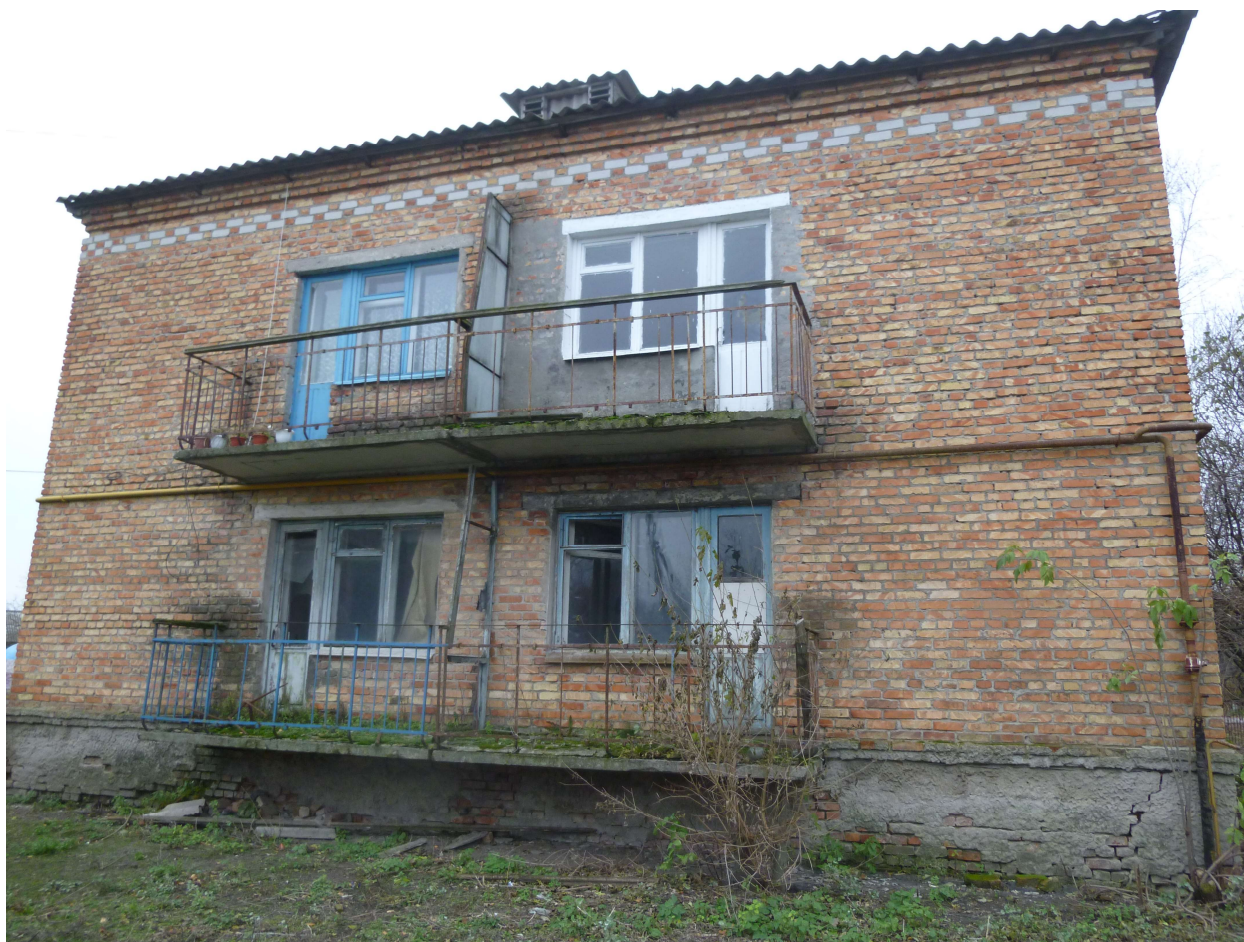
Рис. 2.16 – Загальний вигляд фасаду будівлі ФАП в осях А-В
