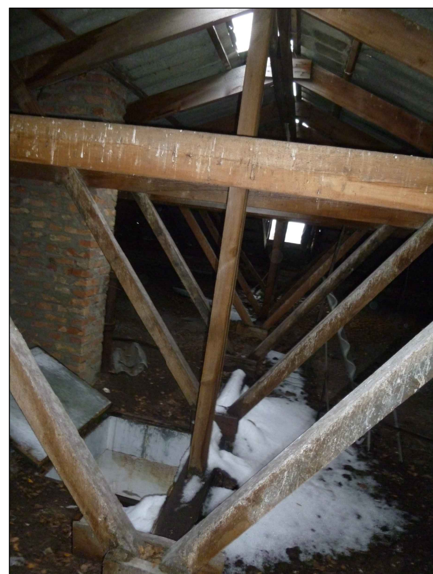
Відсутність гребеневого елемента на покрівлі
