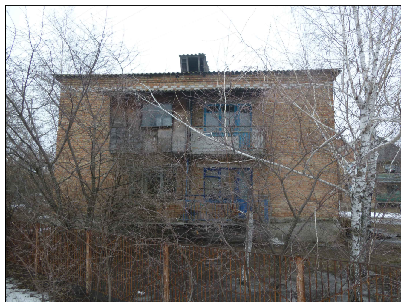
Відсутність гребеневого елемента на покрівлі
