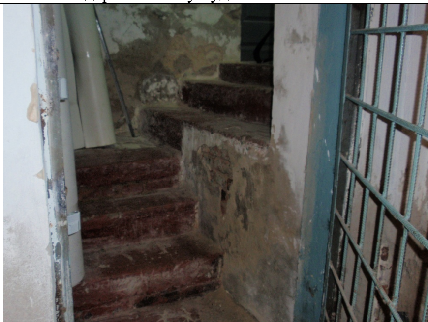
Замочування несучих конструкцій
