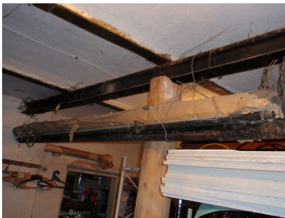
Рис. 2.14 – Загальний вигляд конструкцій перекриття підвальних приміщень учбового корпусу Полтавського обласного центру науково-технічної творчості учнівської молоді ПОР.
