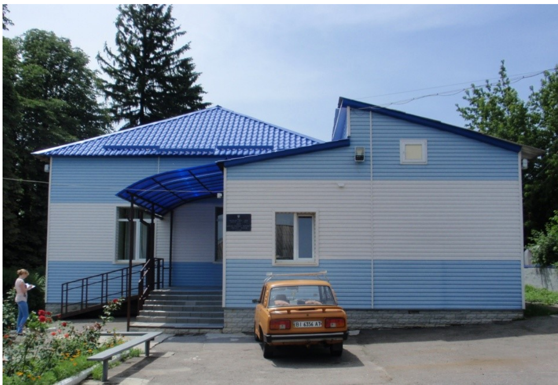
Рис. 2.1 – Загальний вигляд фасаду учбового корпусу в осях А-Г2
