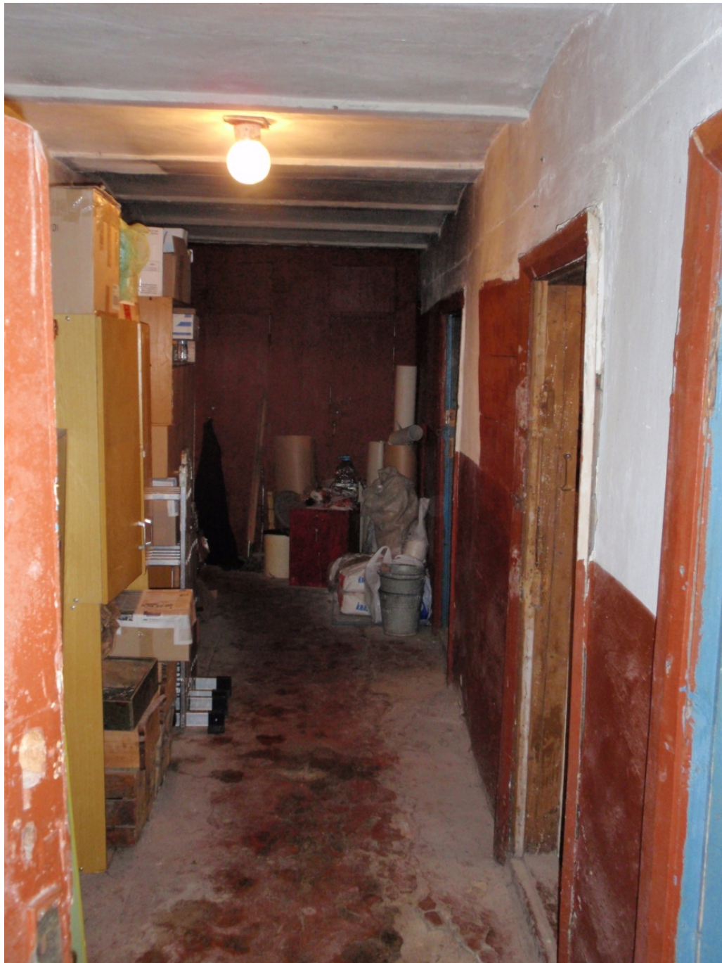
Рис. 2.12 – Загальний вигляд підвальних приміщень учбового корпусу Полтавського обласного центру науково-технічної творчості учнівської молоді ПОР.
