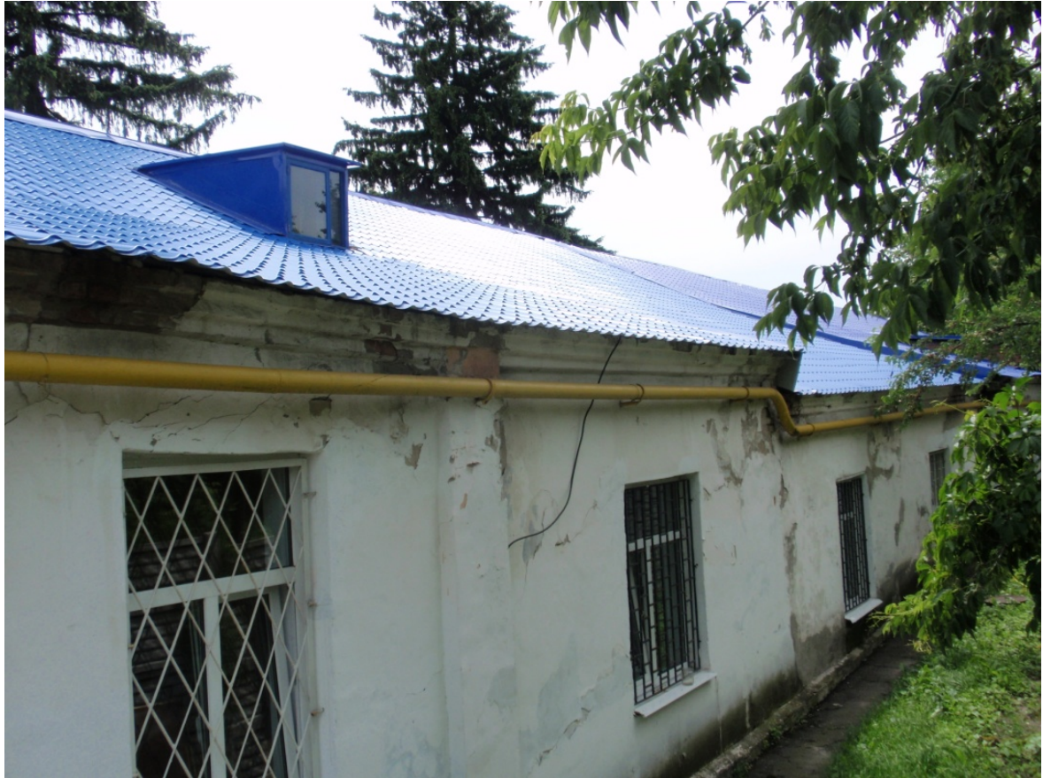
Рис. 2.9 – Загальний вигляд покрівлі учбового корпусу Полтавського обласного центру науково-технічної творчості учнівської молоді ПОР зі сторони фасаду 17-1.
