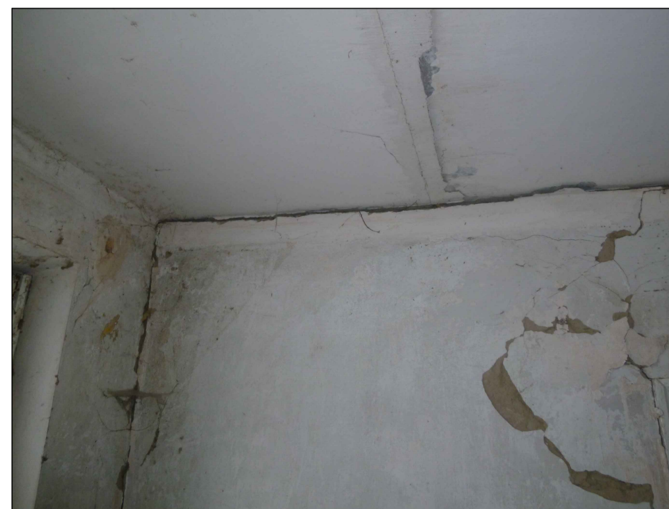
Сліди замокання на поверхні стелі та стін зсередини приміщень будівлі ФАП
