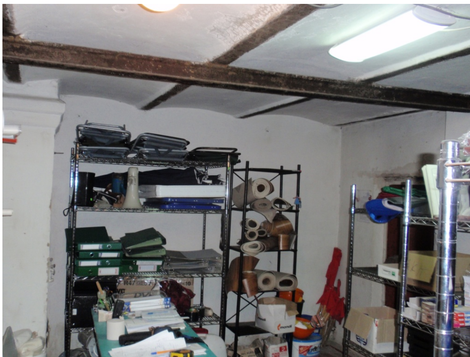
Рис. 2.13 – Загальний вигляд підвальних складських приміщень учбового корпусу Полтавського обласного центру науково-технічної творчості учнівської молоді ПОР.
