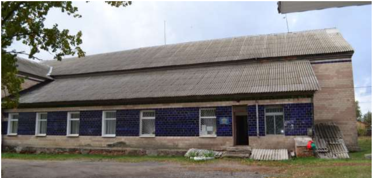
Рис. 1.6 – Загальний вигляд фасаду будівлі в осях Б-Д
