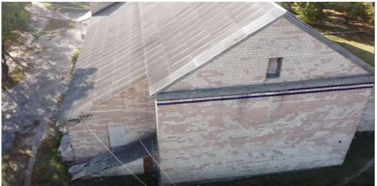
Рис. 1.8 – Загальний вигляд покрівлі
