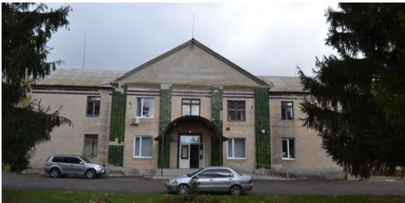
Рис. 1.2 – Загальний вигляд фасаду будівлі в осях 1-6
