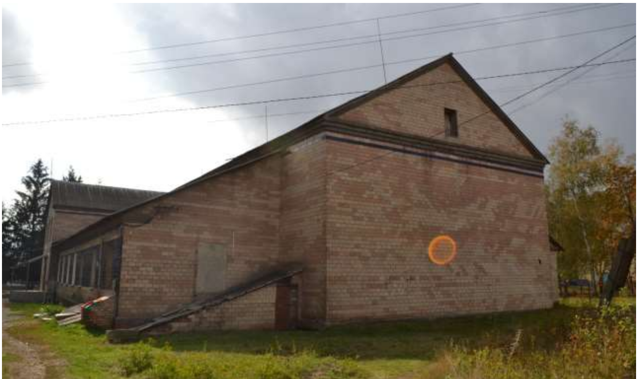
Рис. 1.5 – Загальний вигляд фасаду будівлі в осях 6-2
