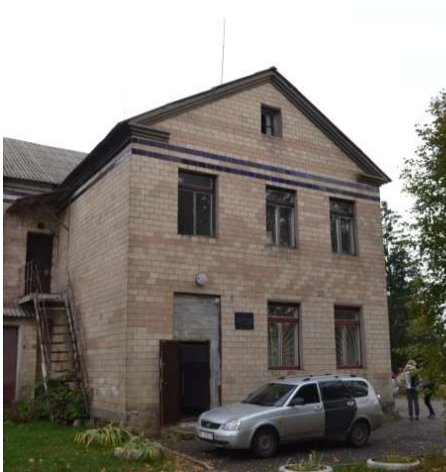
Рис. 1.3 – Загальний вигляд фасаду будівлі в осях Б-А
