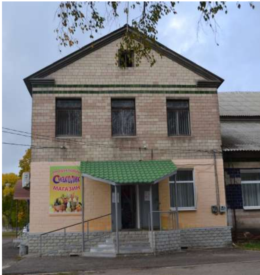
Рис. 1.7 – Загальний вигляд фасаду будівлі в осях А-Б
