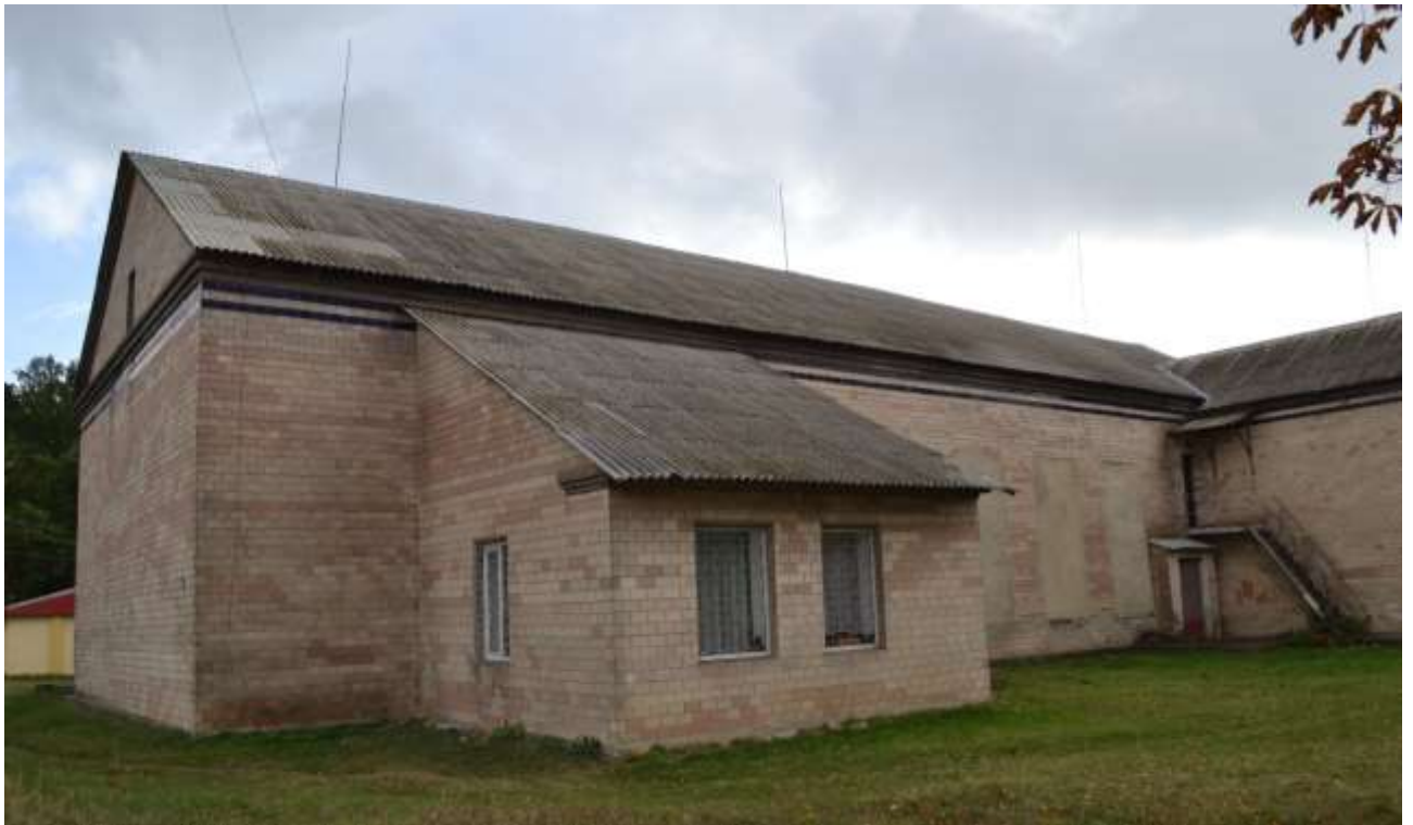
Рис. 1.4 – Загальний вигляд фасаду будівлі в осях Д-Б
