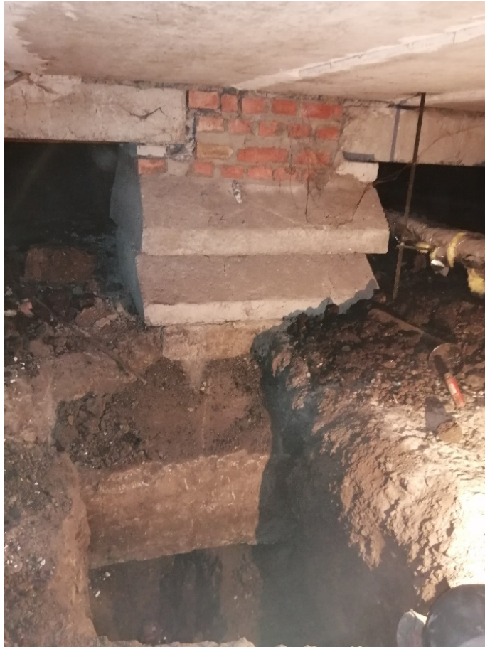
Рис. 3.11 – Видгляд фундаментів у шурфі №4
