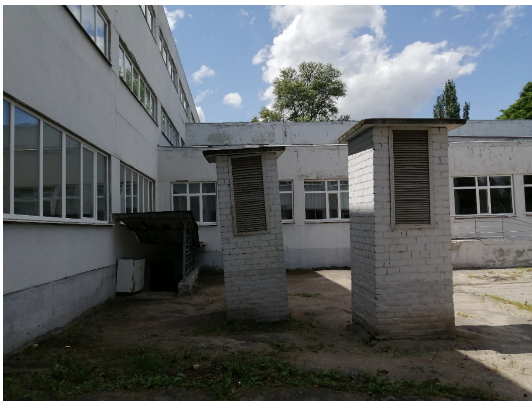
Рис. 3.20 – Безстічний майданчик у внутрішньому дворі будівлі
