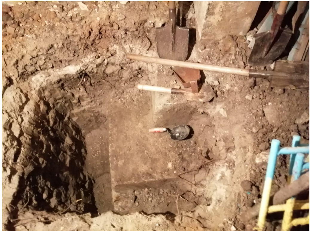
Рис. 3.10 – Видгляд фундаментів у шурфі №3
