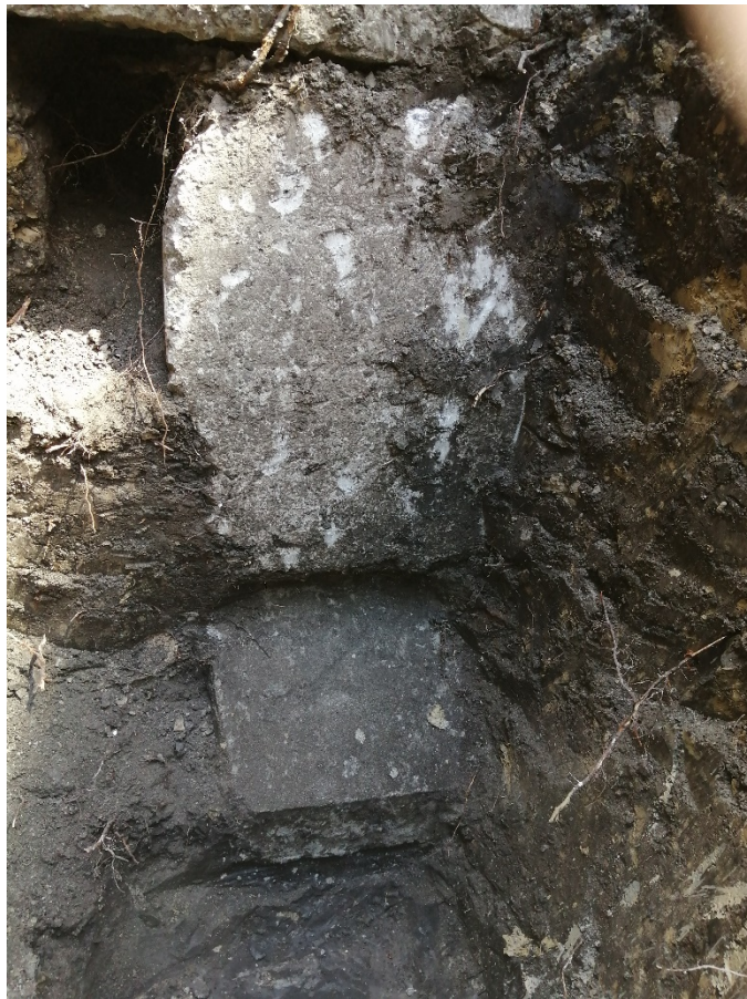
Рис. 3.8 – Вигляд фундаментів у шурфі №2
