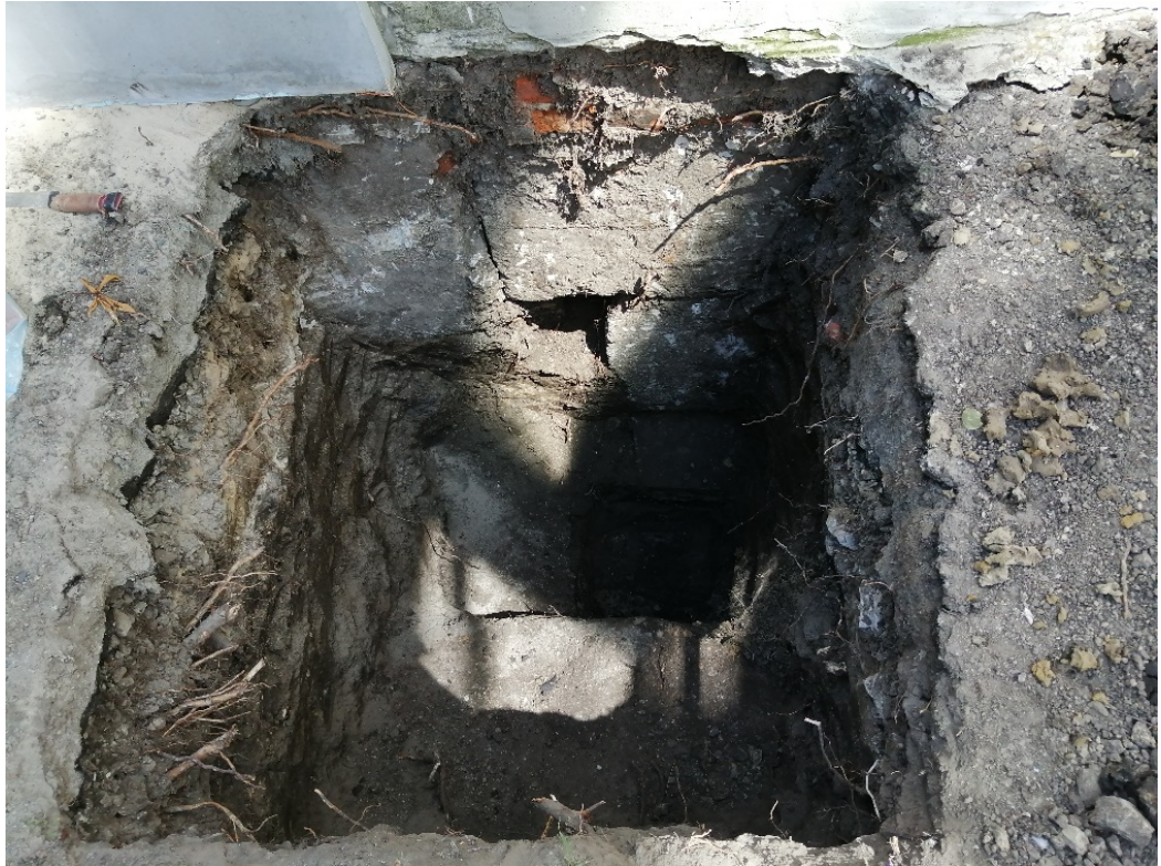
Рис. 3.7 – Вигляд фундаментів у шурфі №2
