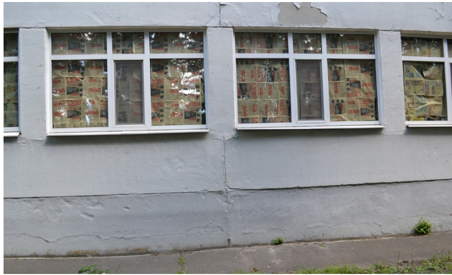
Руйнування оздоблювального шару та вивітрювання будівельного розчину між залізобетонними стіновими панелями
