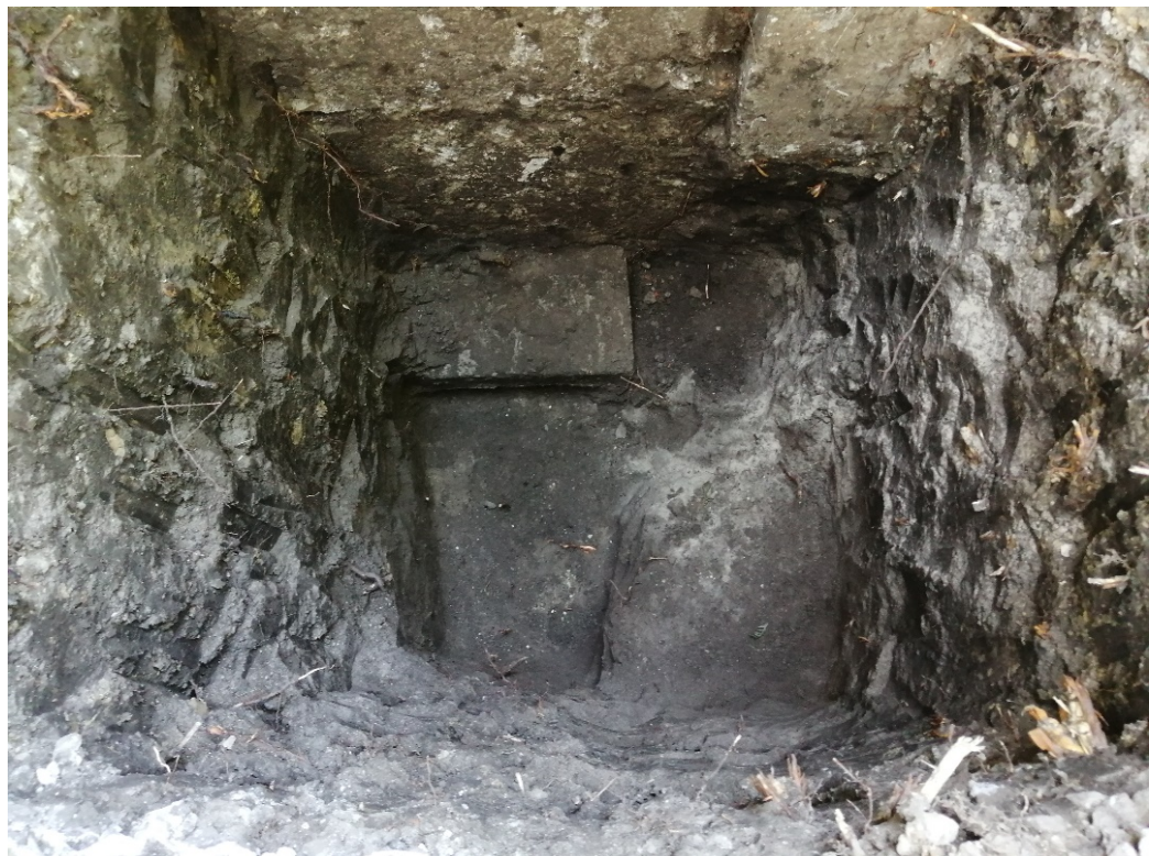
Рис. 3.6 – Вигляд фундаментів у шурфі №1
