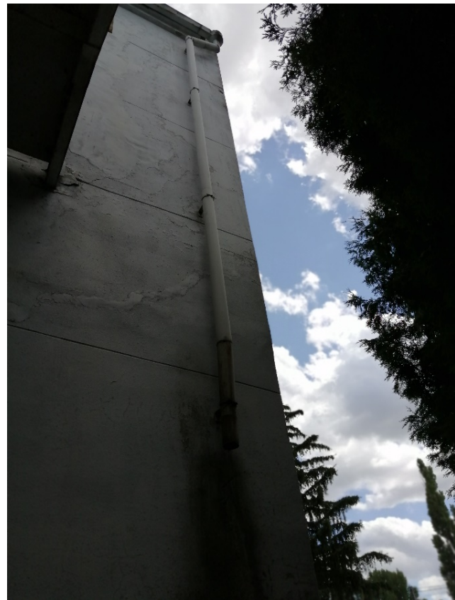
Рис. 3.22 – Вивід атмосферних вод з покрівлі поруч з фундаментами будівлі
