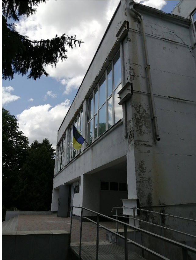
Рис. 3.21 – Вивід атмосферних вод з покрівлі поруч з фундаментами будівлі
