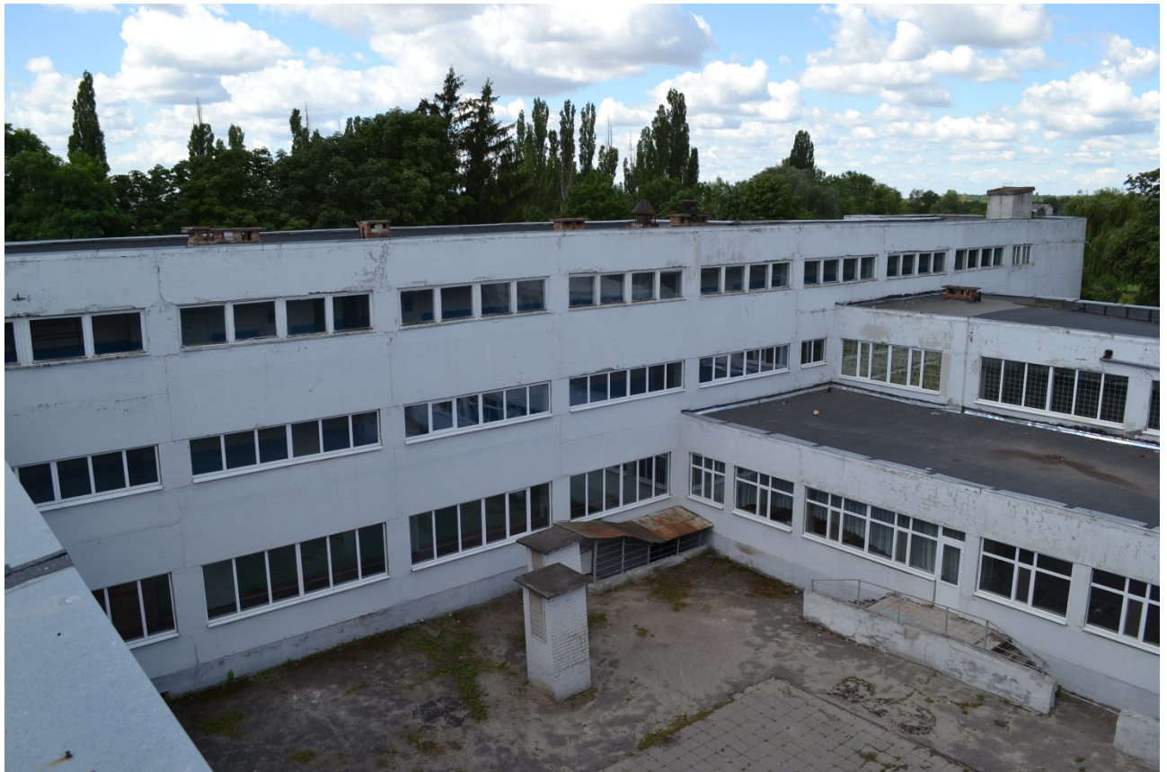
Рис. 2.4 – Загальний вигляд фасаду будівлі в осях 15-1
