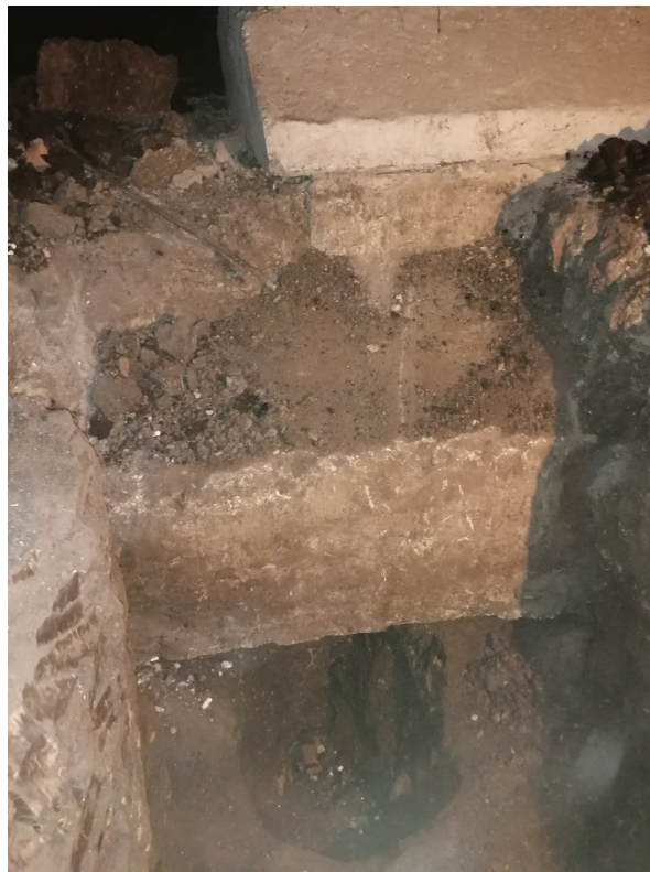
Рис. 3.12 – Видгляд фундаментів у шурфі №4
