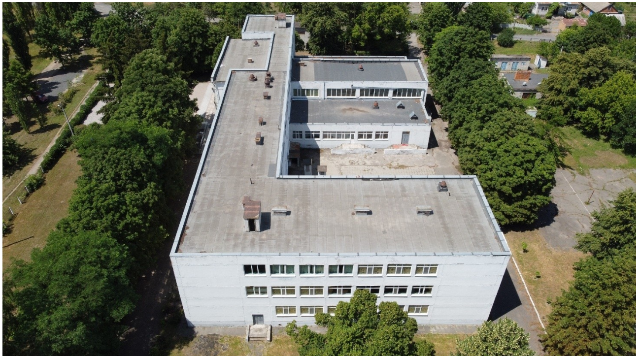
Рис. 2.3 – Загальний вигляд фасаду будівлі в осях Б-М
