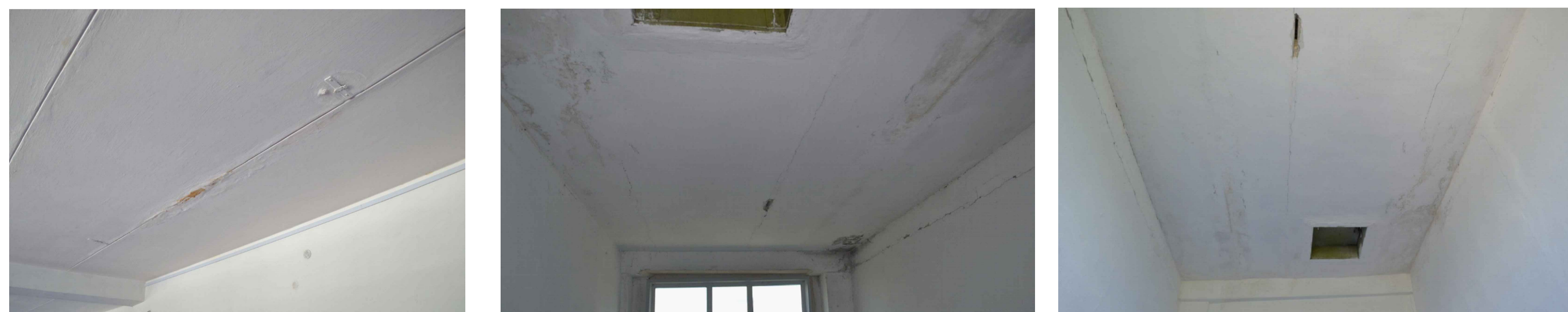
Замокання стелі. Випадіння швів між плитами покриття
