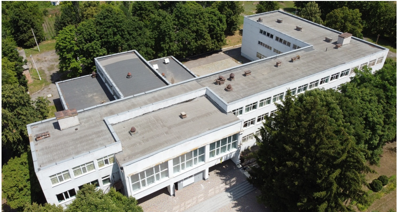
Рис. 2.2 – Загальний вигляд фасаду будівлі в осях 1-15
