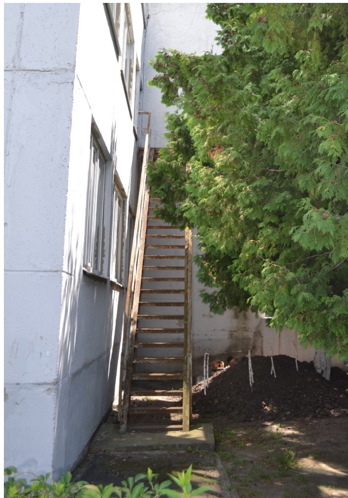
Рис. 2.12 – Металеві сходи з другого поверху в осях 1-3
