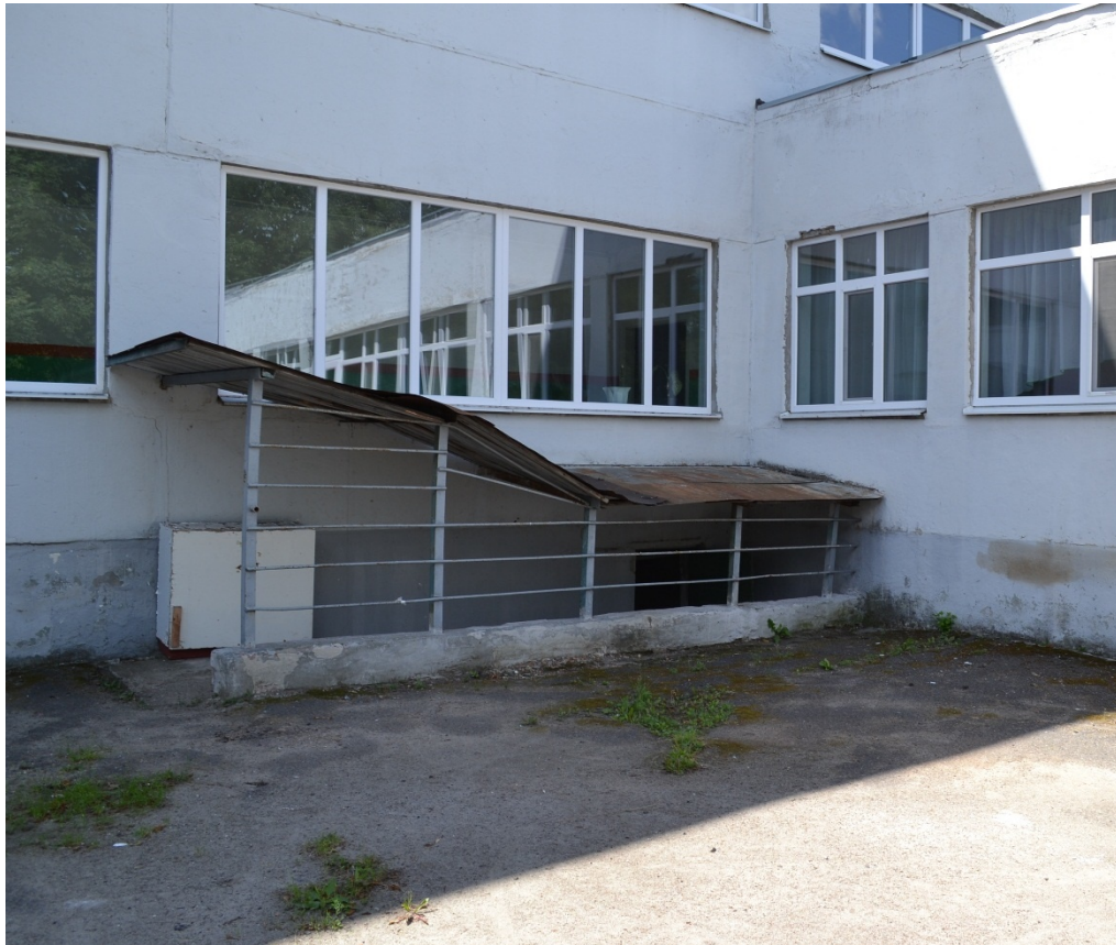
Рис. 2.14 – Вхід до підвальної частини по осі Г (9-10)
