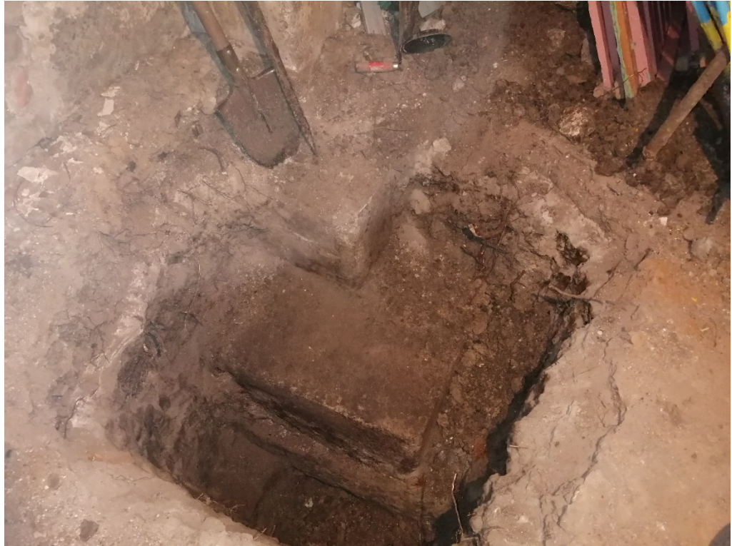
Рис. 3.9 – Видгляд фундаментів у шурфі №3
