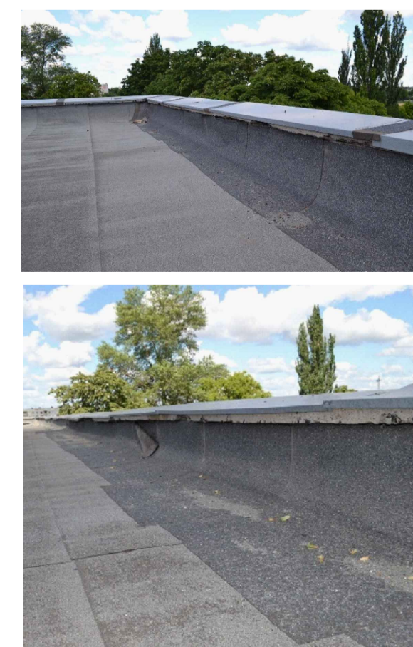
Відсутність прижимної планки, як наслідок відшарування покрівельного килима.
