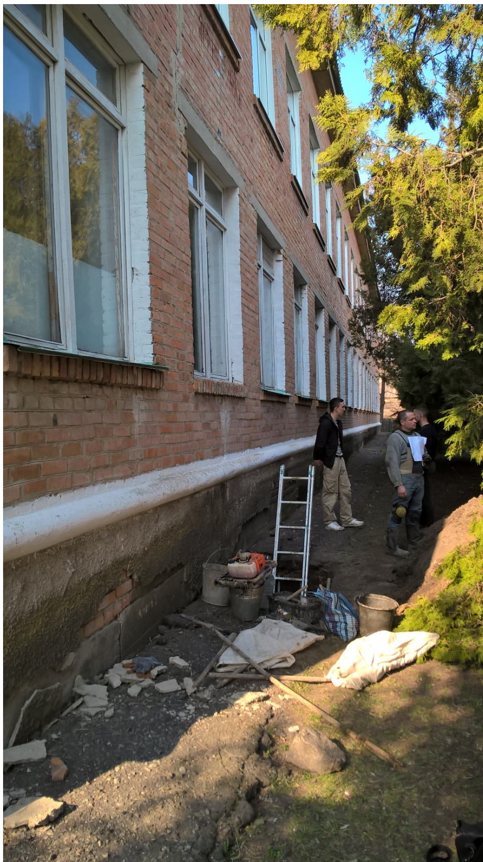
Рис. 4.15 – Шурф №2 з фасаду будівлі (вісь А)
