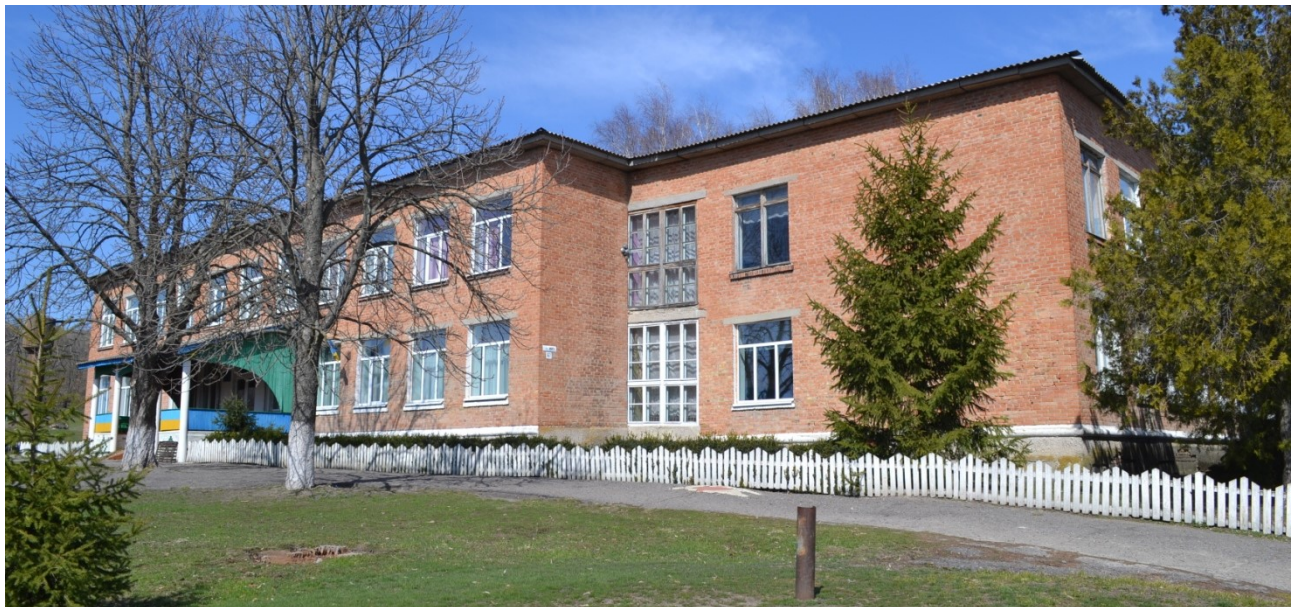
Рис. 2.3 – Загальний вигляд будівлі в осях А-К
