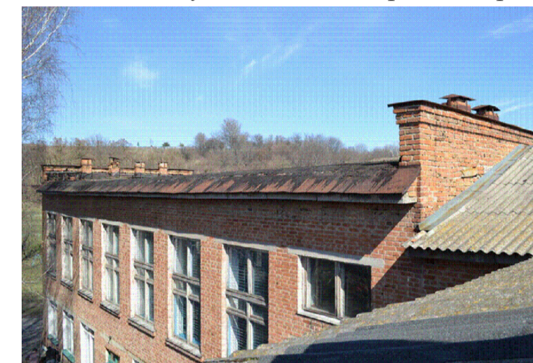
Руйнування цегляної кладки вентиляційних каналів. Відсутня захисна огорожа покрівлі.
