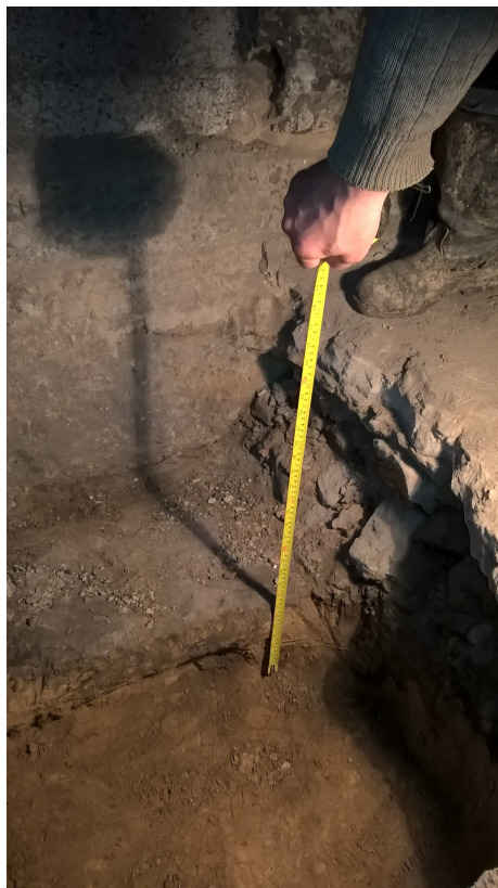
Рис. 4.14 – Шурф №1 у підвалі будівлі (вісь 4)
