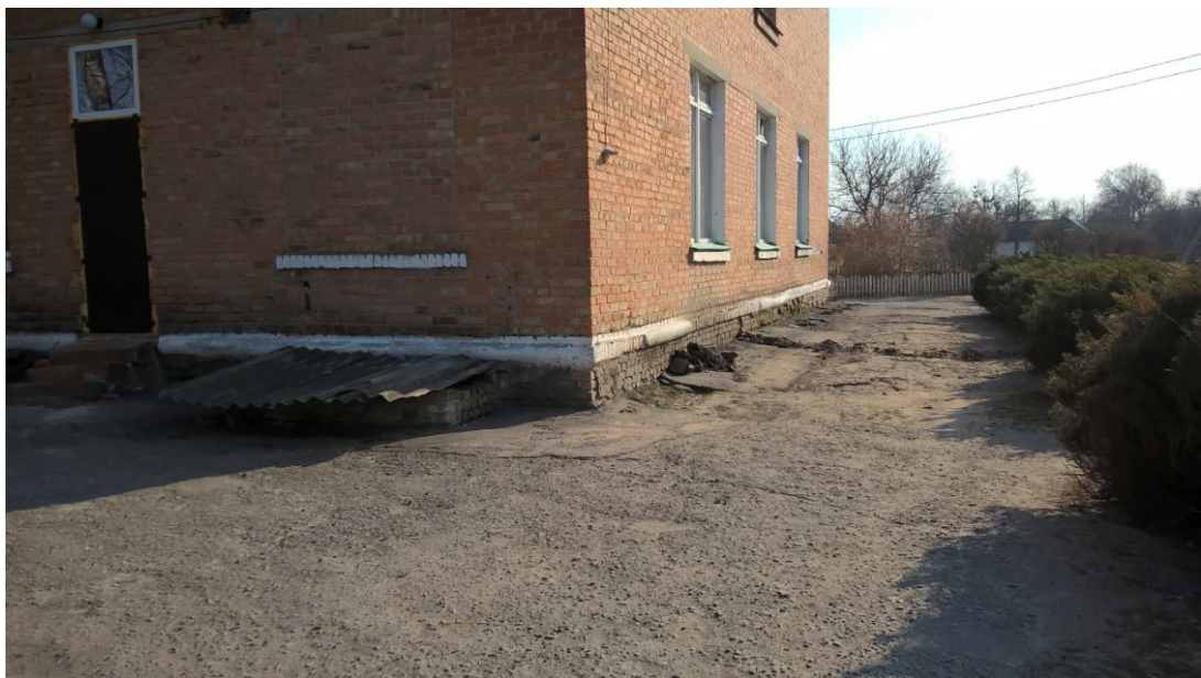
Рис. 4.21 – Стан вимоцнення навколо будівлі (вісь К), місце вводу водонесучих комунікацій
