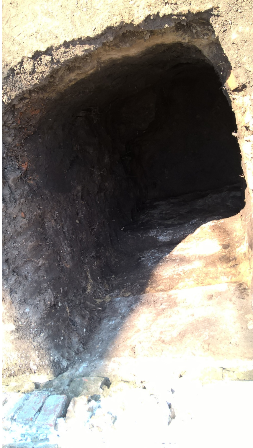
Рис. 4.17 – Шурф №4 у дворі будівлі (вісь 7)
