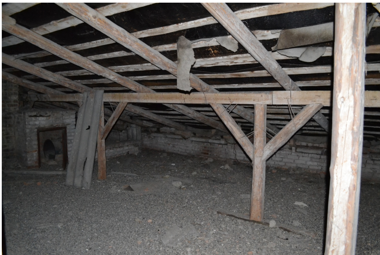
Рис. 2.5 – Загальний вигляд горища в осях Г-К (Блок 1)
