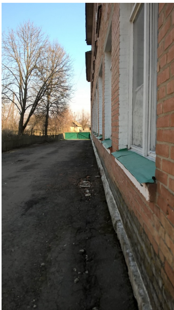
Рис. 4.19 – Стан вимощення навколо будівлі (вісь 9), тріщини в несучій стіні будівлі
