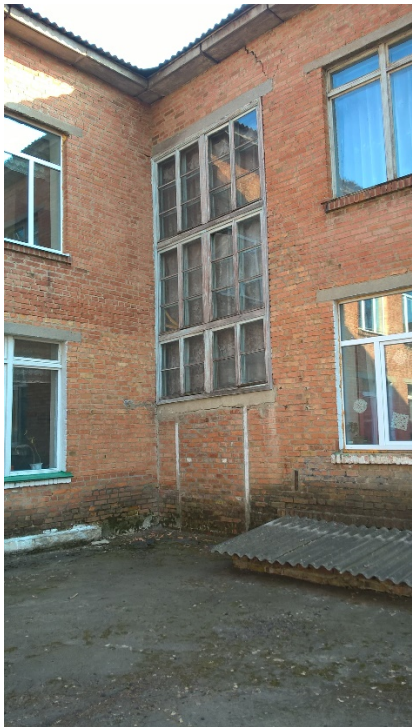
Рис. 4.23 – Тріщини в несучих стінах будівлі (у дворі та на фасаді)
