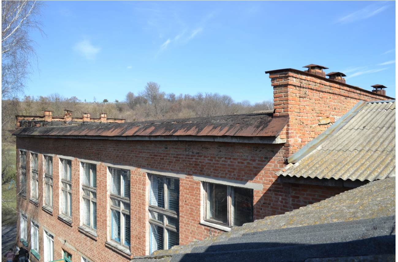
Рис. 2.7 – Загальний вигляд покрівлі будівлі блоку 3
