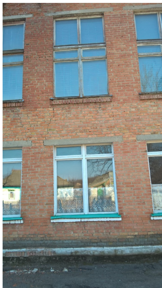
Рис. 4.19 – Стан вимощення навколо будівлі (вісь 9), тріщини в несучій стіні будівлі
