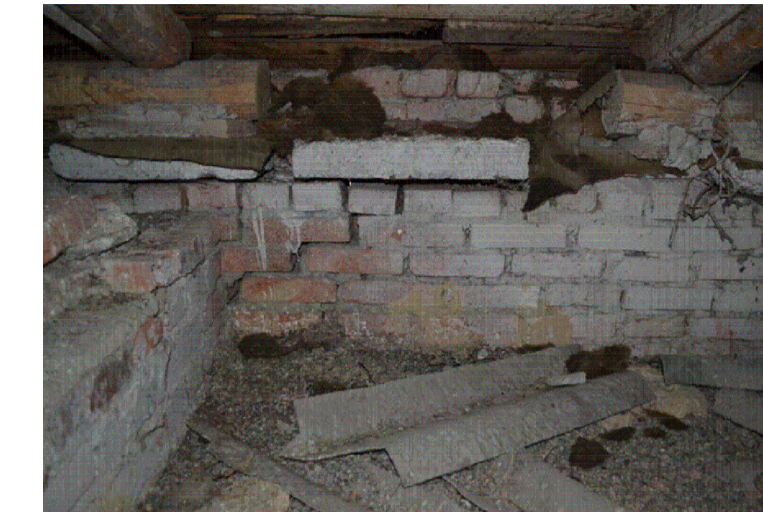
Руйнування цегляної кладки вентиляційних каналів. Відсутня захисна огорожа покрівлі.
