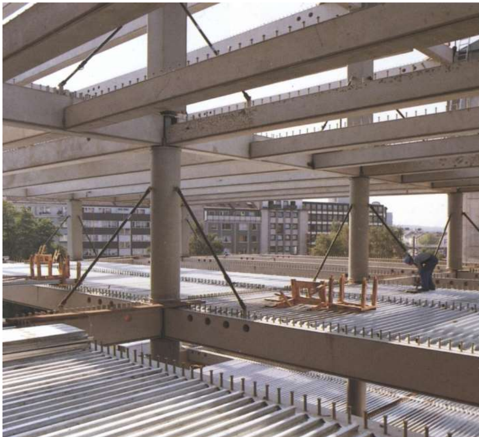
Рисунок 1.6 – Сталезалізобетонний каркас багатоповерхової виробничої будівлі фірми Зіменс, м. Берлін ([15], стор. 49)
