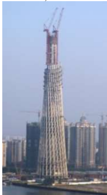
Рисунок 1.4 – Будівництво телевежі із застосуванням сталезалізобетону в Гуанчжоу (Китай):
