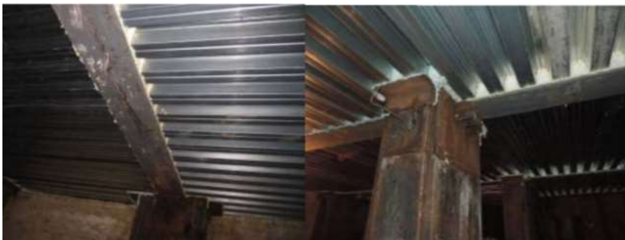
Рисунок 1.9 – Приклад використання сталезалізобетонного перекриття пониженої висоти при реконструкції будівлі ([18], стор. 12)
