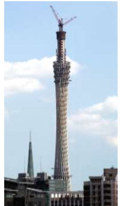
Рисунок 1.4 – Будівництво телевежі із застосуванням сталезалізобетону в Гуанчжоу (Китай):
