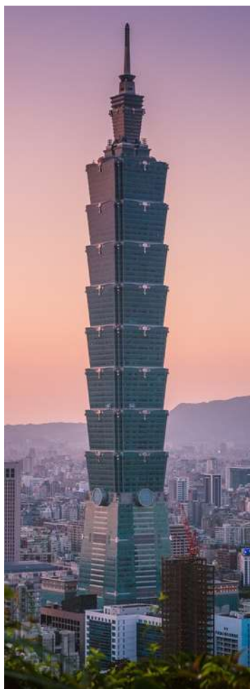
Рисунок 1.5 – Висотна будівля Тайбей 101 з комбінованими сталезалізобетонними несучими конструкціями в Тайвані (Китай):
