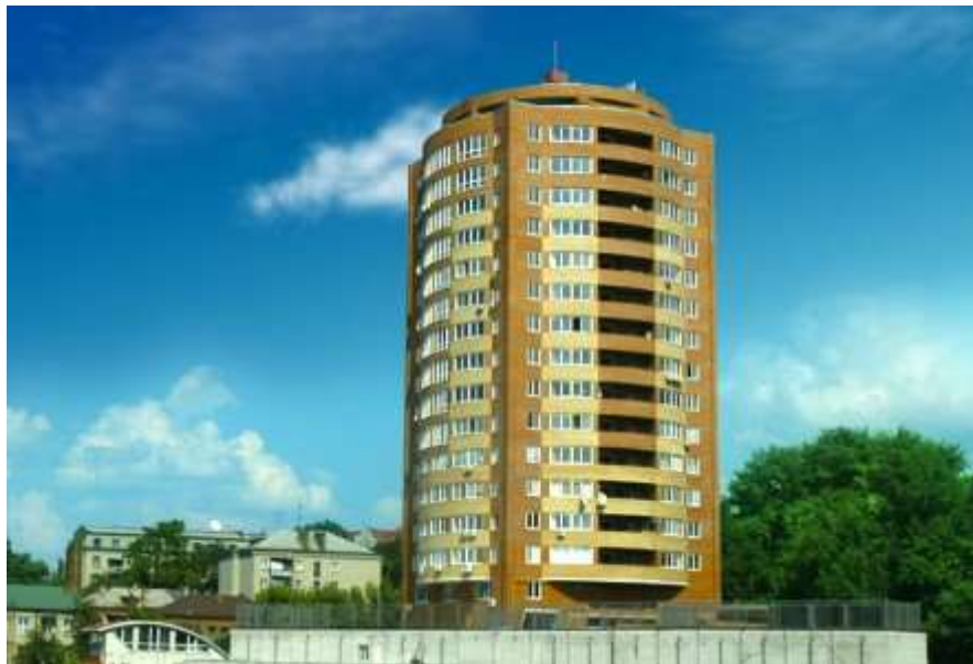
Рисунок 1.7 – Будівля з трубобетонних конструкцій адміністративно-житлового комплексу (АЖК) «Аркадієвська вежа» (Україна) ( https://sozidatel.dp.ua/wp-content/uploads/2020/02/117_large-300x203.jpg )
