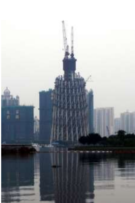
Рисунок 1.4 – Будівництво телевежі із застосуванням сталезалізобетону в Гуанчжоу (Китай):
