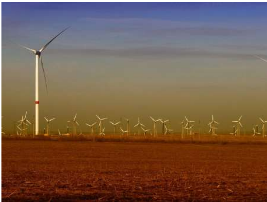
Рис.1.14- Новоазівська вітроелектростанція ( https://uk.wikipedia.org/wiki/Новоазовська_ВЕС )
