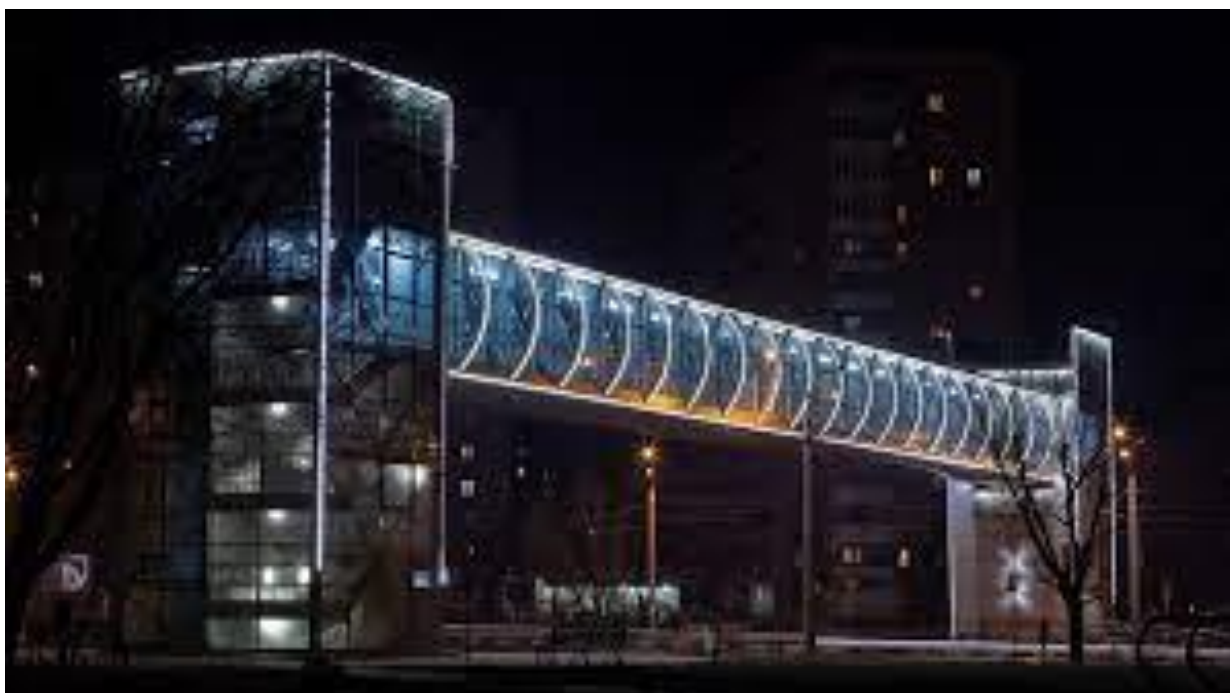
Рис.2.17. Надземний пішохідний міст у м.Харків
