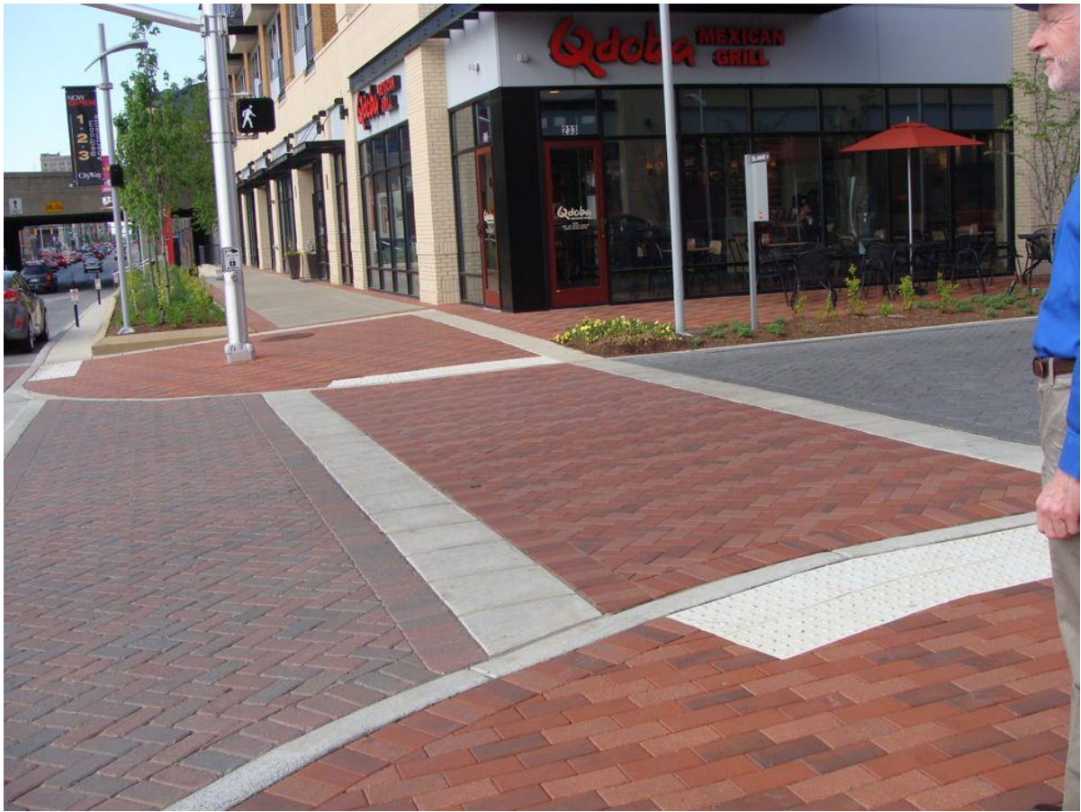
Рис. 2.9. Приклад піднятого пішохідного переходу
