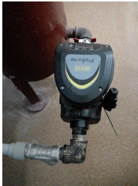
Рис. 4. Циркуляційний насос DAB Evoplus
