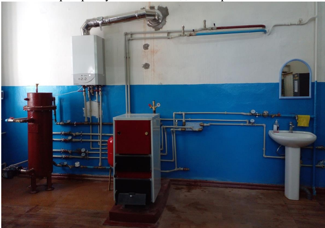
Рис. 2. Фото лабораторної установки для дослідження роботи теплогенеруючих установок на природному газі та твердому паливі
