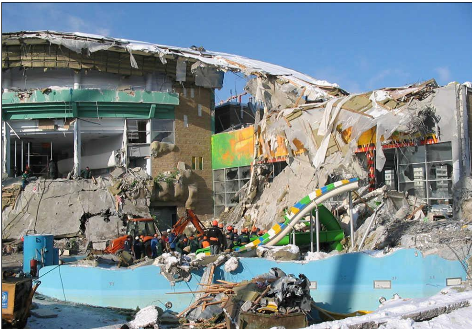
Рис. 3.3. Обвалення покриття спортивного комплексу ( м. Бад-Райхенваль, Німеччина)
