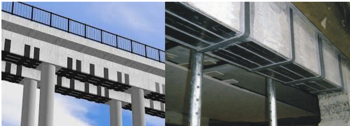
Рис. 4.7. Залізобетонні балки, підсилені вуглепластиком
