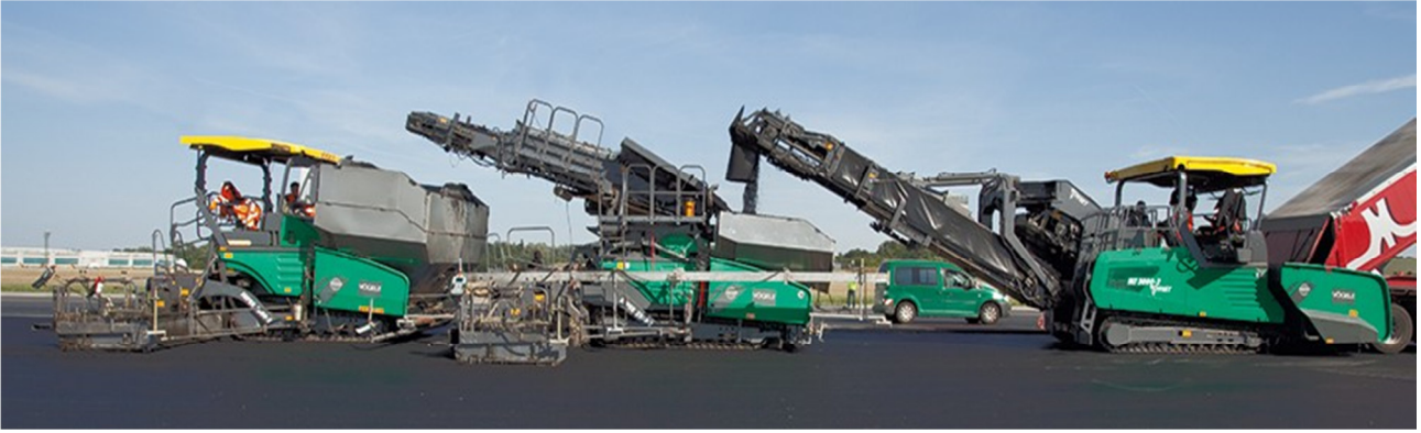
Рисунок 1 – Влаштування покриття за технологією «Vögele InLine Pave®»
