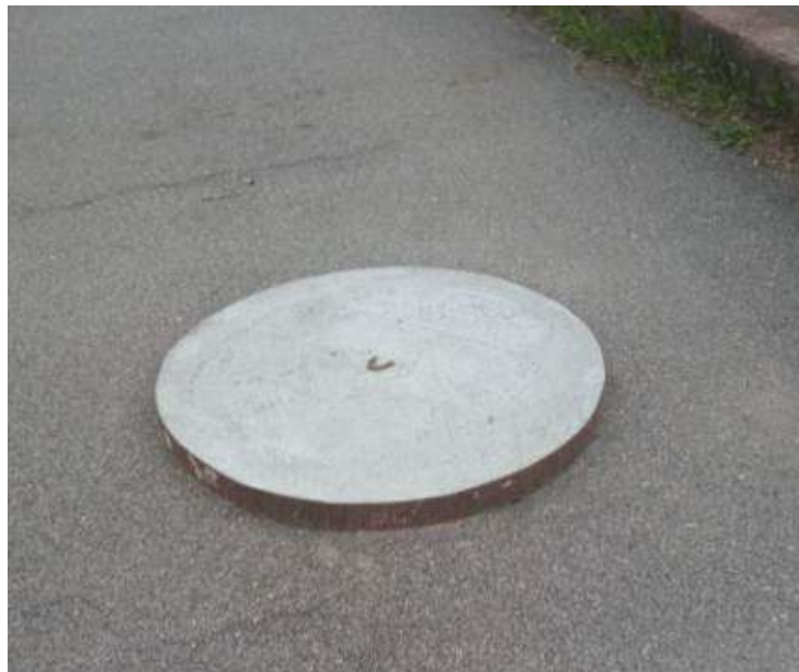
Рис. 1 – Використання круглих сталобетонних плит у міській інфраструктурі
