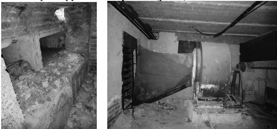
Рис. 3. Система припливної вентиляції корпусу «Ф» до реконструкції
