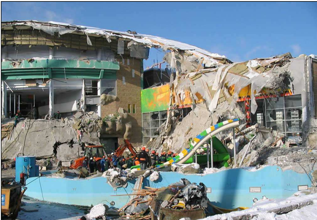
Рис. 2.3. Обвалення покриття спортивного комплексу ( м. Бад-Райхенваль, Німеччина)
