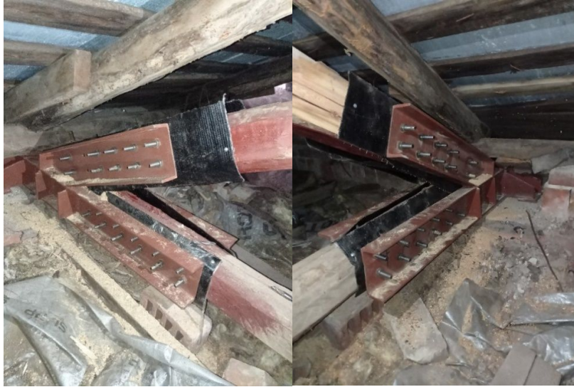
Рис. 1 . Загальний вигляд вузлів підсилення дерев'яних кроквяних ферм
