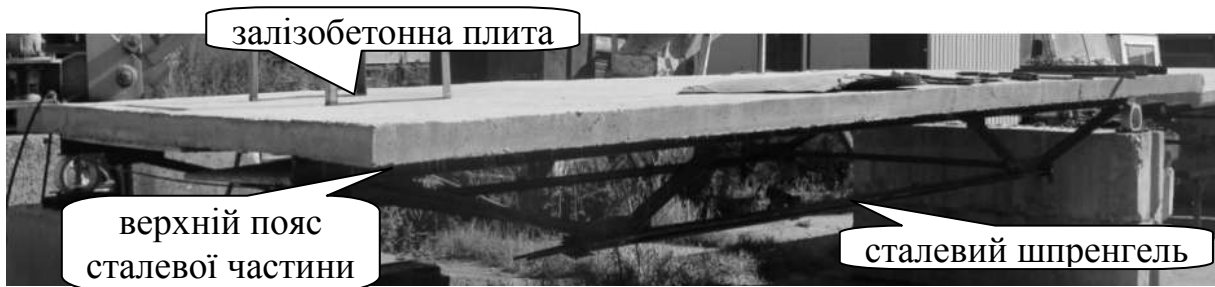
Рис. 1.22 – Однопролітна сталезалізобетонна шпренгельна конструкція [89]
