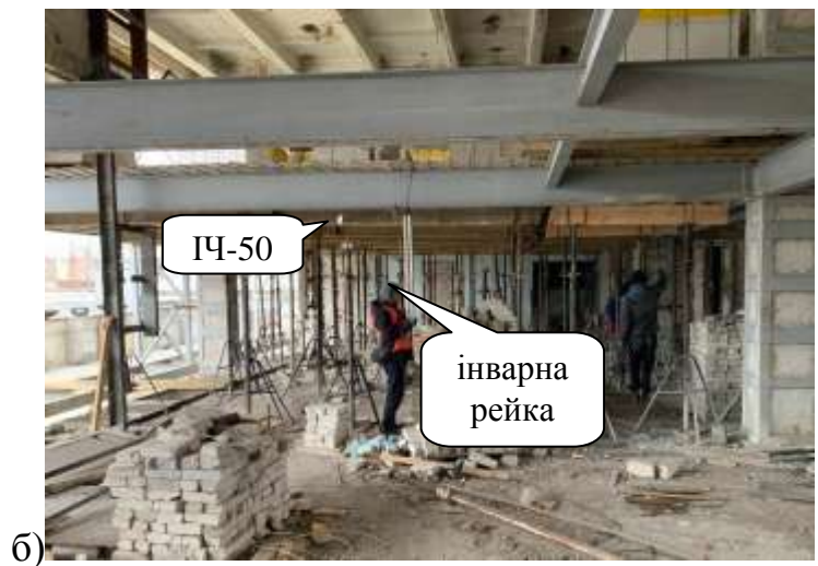
Рис. 4.31 – Проведення нівелювання вертикальних переміщень контрольних точок сталевих балок
