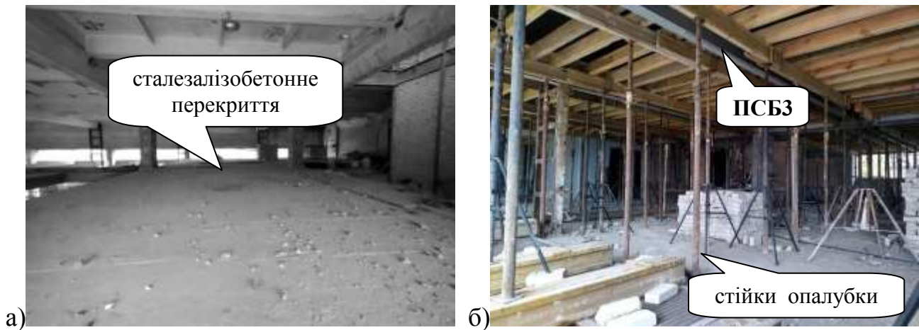
Рис. 4.29 – Загальний вигляд на сталезалізобетонне перекриття:
