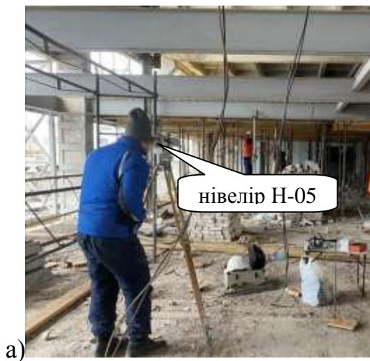
Рис. 4.31 – Проведення нівелювання вертикальних переміщень контрольних точок сталевих балок
