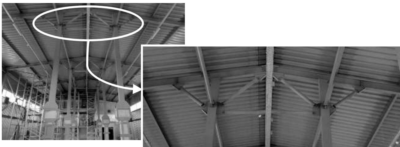
Рис. 2.6 – Встановлення підкосів між колонами та балками для забезпечення поперечної жорсткості рам будівель
