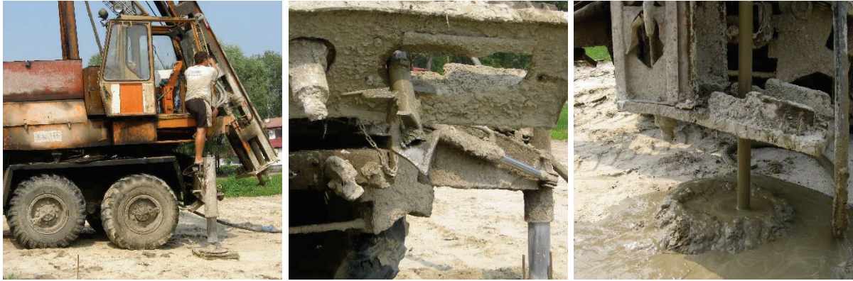
Рисунок 2 – Бурозмішувальна технологія виготовлення цементогрунту
