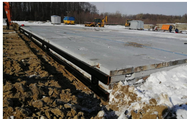
Рисунок 1 – Просторовий вигляд і фото фундаменту під буровий верстат
