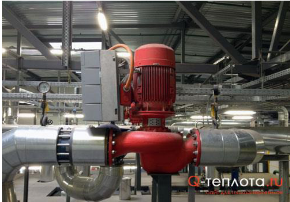
Рис .3.3 Рекомендована схема встановлення мережевого насосу
