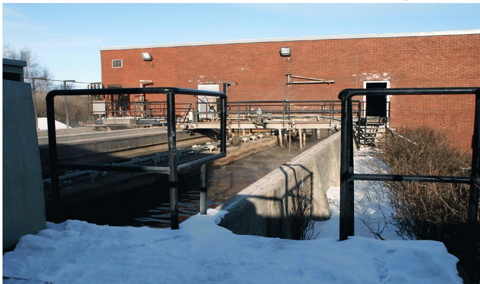
Рис. 3.9 Горизонтальний аераційний пісковловлювач
