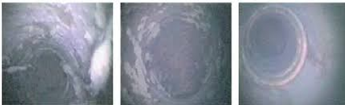
Рисунок. Внутренняя поверхность водопровода: а) с использованием гипохлорита натрия; б) через 6 дней использования смеси окислителей; в) после 22 дней использования смеси диоксида хлора и оксидов.
