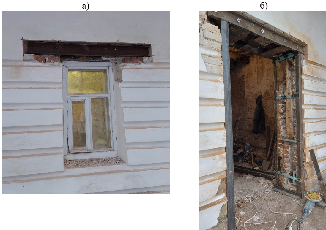
Рис. 1. Підсилення несучої стіни для виконання дверного отвору на місці віконного: а) влаштування перемички з двох швелерів перед виконанням дверного отвору; б) влаштування обойми з кутиків на дверному отворі.
