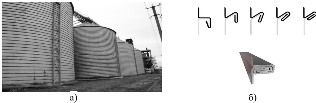
Рис. 1. Спірально-фальцеві силоси; а) - елеватор с. Ємилівка, Кіровоградська область, 1971 р., б) фальцевий замок
