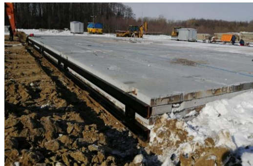
Рис. 2. Просторовий вигляд і фото фундаменту під буровий верстат
