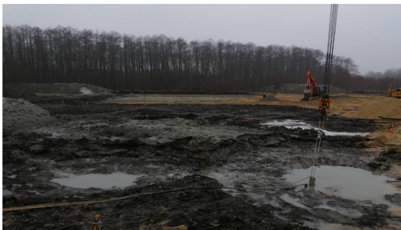
Рис. 1. Вигляд ділянки в районі річкової заплави під монтаж бурового верстату
