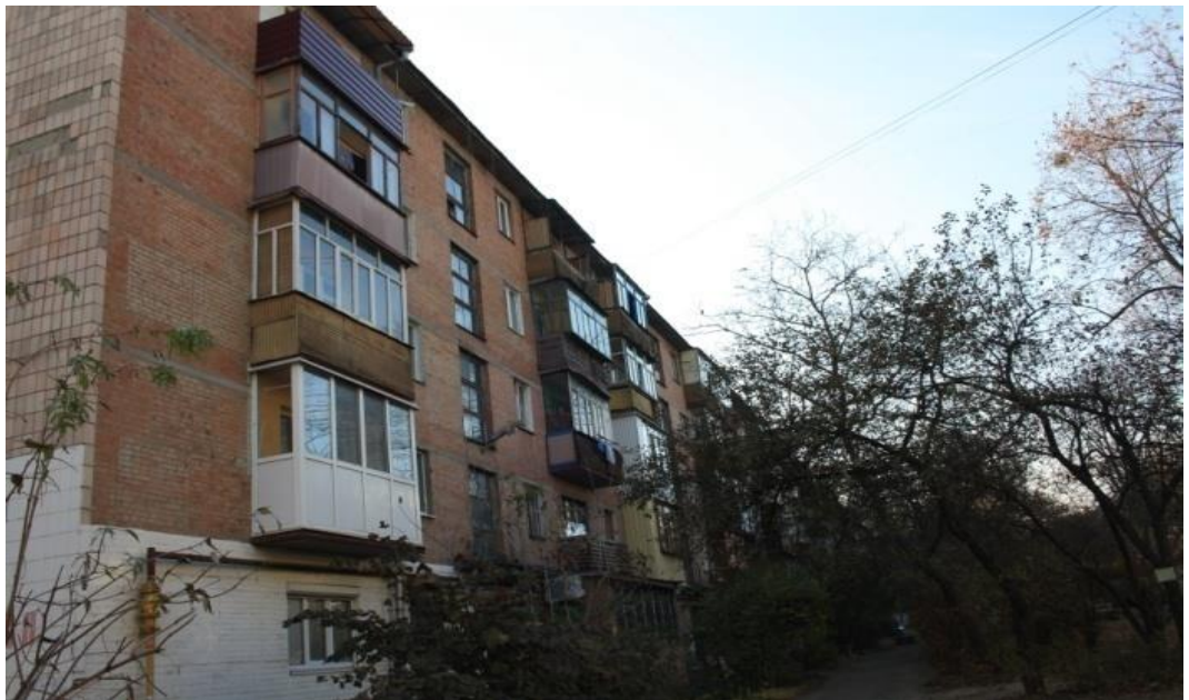
Рис. 6.2 – Північно-західний фасад житлового будинку по вул. Героїв АТО, 19
