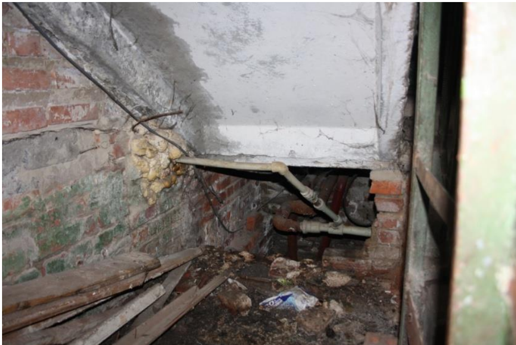
Рис. 6.3 – Підвальне приміщення з прокладеними розподільчими трубопроводами житлового будинку по вул. Героїв Ато, 19
