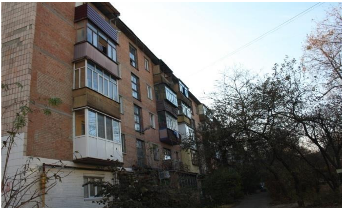
Рис.3.1. Північно-західний фасад будинку по вул. Героїв АТО, 19 Зовнішні стіни:
