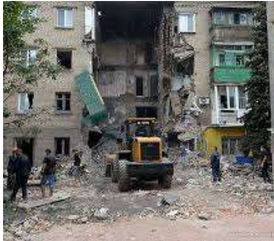
Рисунок 1.5 – Стан будинку після вибуху газу
