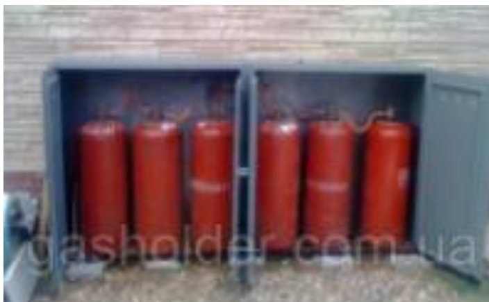
Рисунок. Групова зовнішня установка балонів
