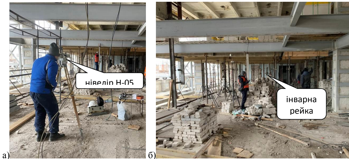
Рис. 2. Проведення нівелювання вертикальних зміщень контрольних точок балок
