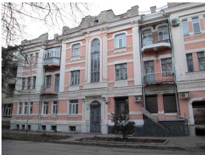
Рис. 1. Загальний вигляд будинку по вул. Котляревського, 30
